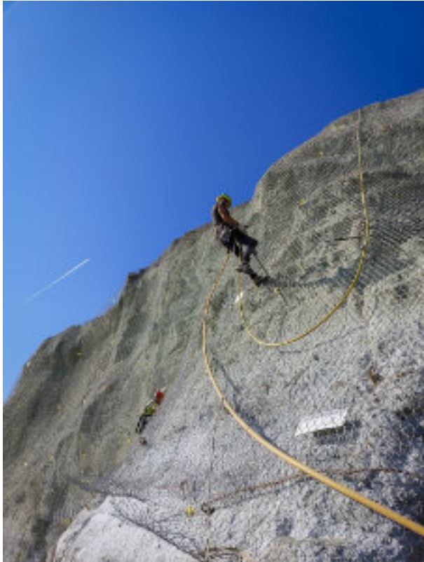
Montage von Schutznetzen
