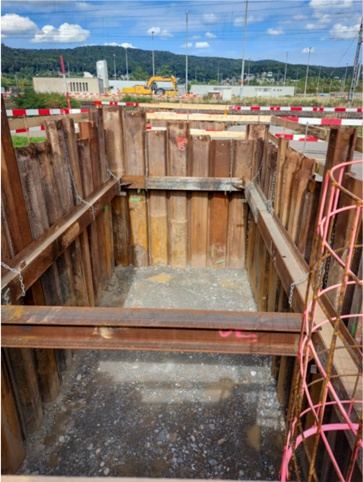
Von hier wird der Vortrieb unter den Gleisen für die neuen Kabelkanäle durchgeführt
