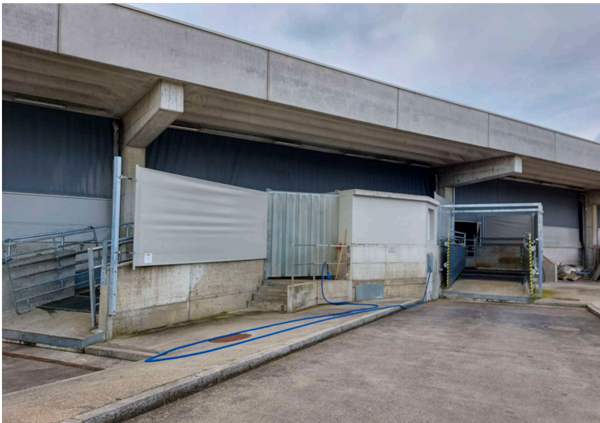
Hier werden die Schlachttiere angeliefert.
