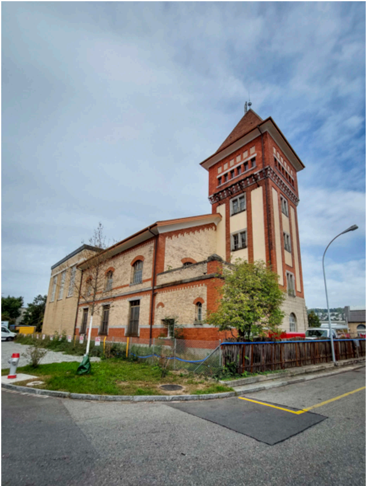
Ehemalige Transformatorstation der EWZ. Sie diente der Versorgung des Schlachtofes mit elektrischer Energie. Der Strom kam aus den Albulawerken.
