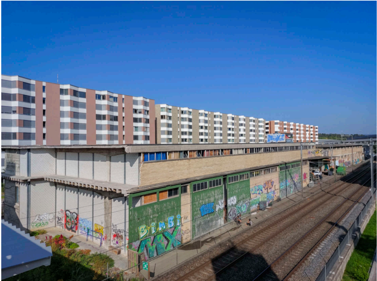
Diese ehemaligen Lagerhäuser werden abgerissen.
