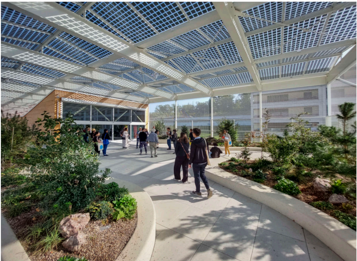
Auf dem Dach: Die Beschattungsstoren sind mit Solarzellen ausgerüstet
