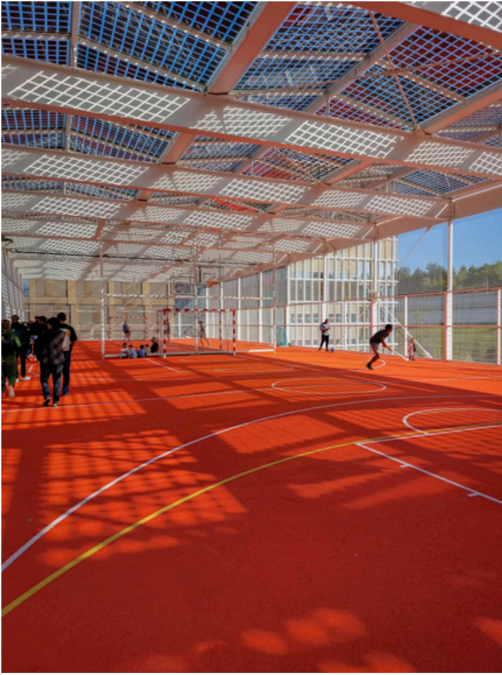
Sportplatz auf dem Dach
