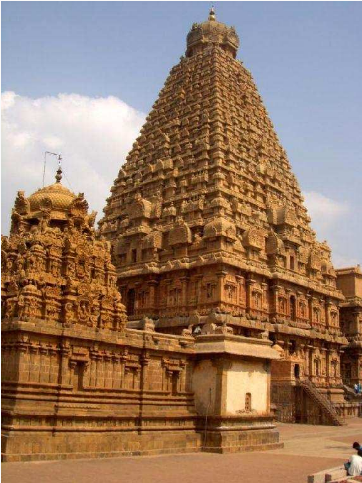
Die Kuppel auf 70m Höhe besteht aus zwei Teilen und wiegt insgesamt über 80 Tonnen. Für deren Transport und Positionierung wurde dazumal eine Rampe von 11 km Länge gebaut
