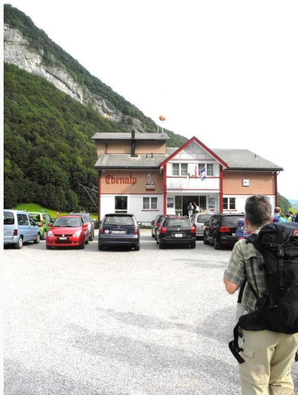
Talstation der Ebenalp-Bahn in Wasserauen
