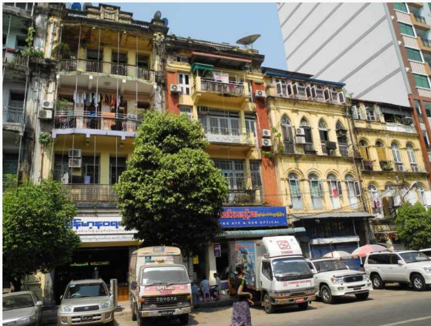
Über hundertjährige Gebäude dürfen nicht abgerissen werden
