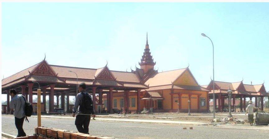
Der kambodschanische Grenzposten (im Bau)
