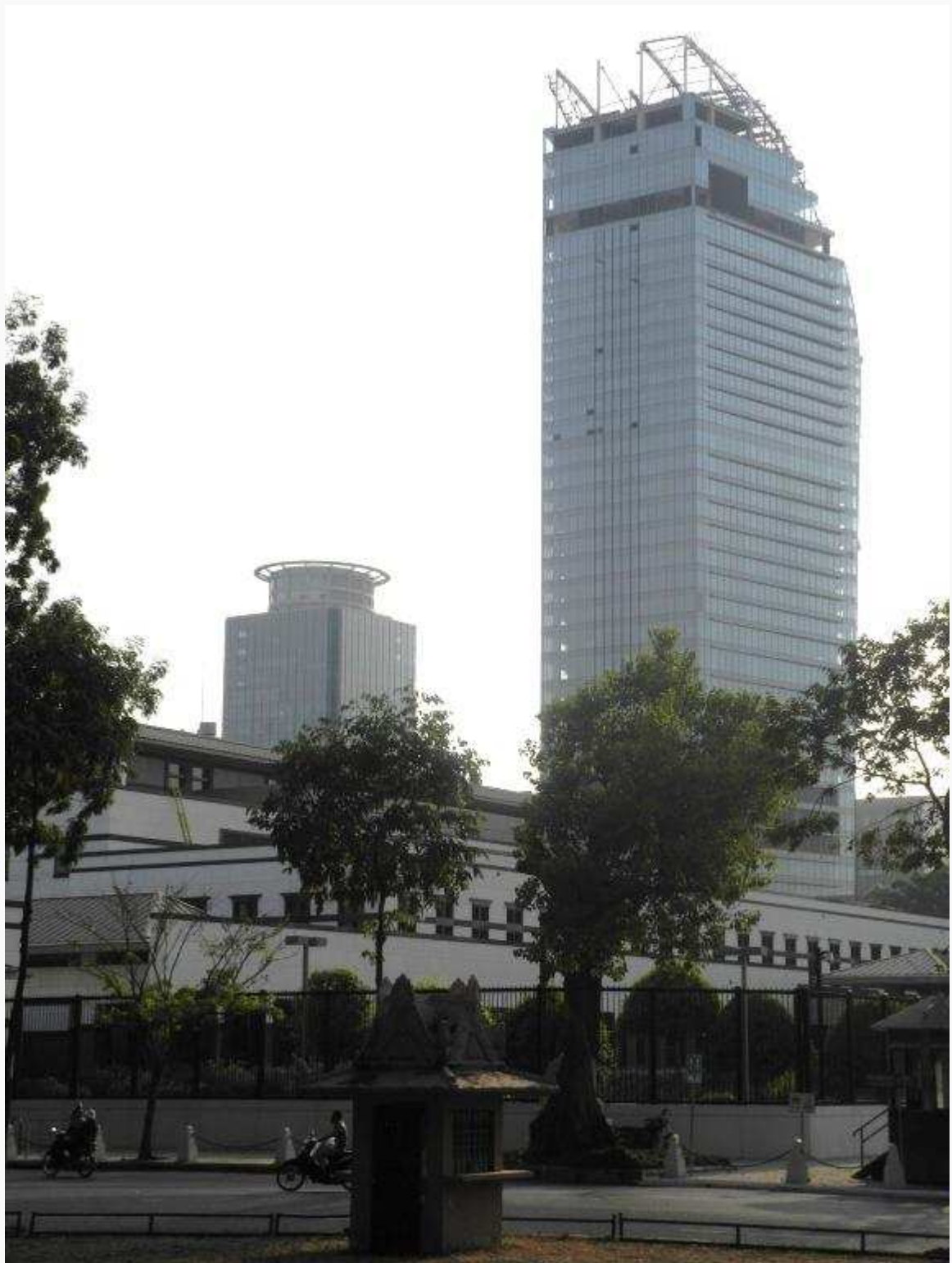
Es wird viel gebaut
