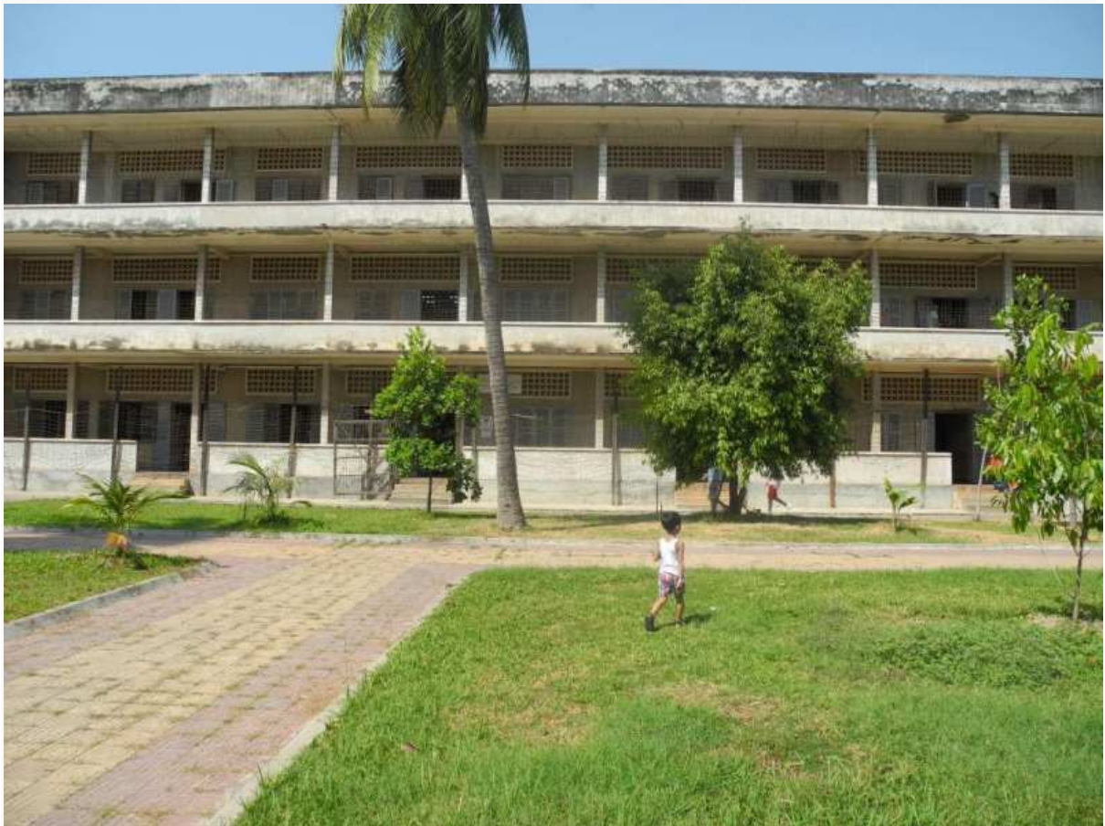
Der Besuch des Völkermord-Museums Toul Sleng gehört zu den bedrückendsten Erlebnissen unserer Reise. Die Roten Khmer hatten in diesen Räumen einer ehemaligen Schule ein Gefängnis, Verhör- und Folterzentrum eingerichtet. Hier und in den nahe gelegenen Killing Fields wurden zwischen 1975 und 1979 über 20 000 Menschen auf bestialische Weise ermordet
