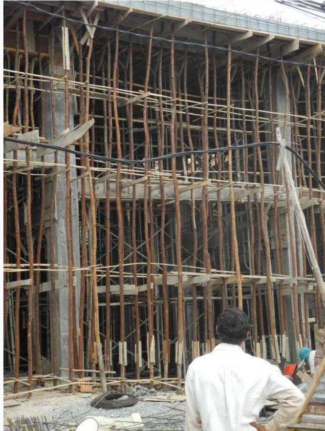
Es wird viel gebaut ...
