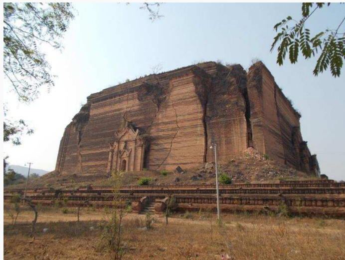
Ausdruck des Grössenwahns: Dieser 50m hohe Steinhau- fen hätte einmal die höchste Pagode der Welt werden sol- len (150m). Die Risse stammen von Erdbeben
