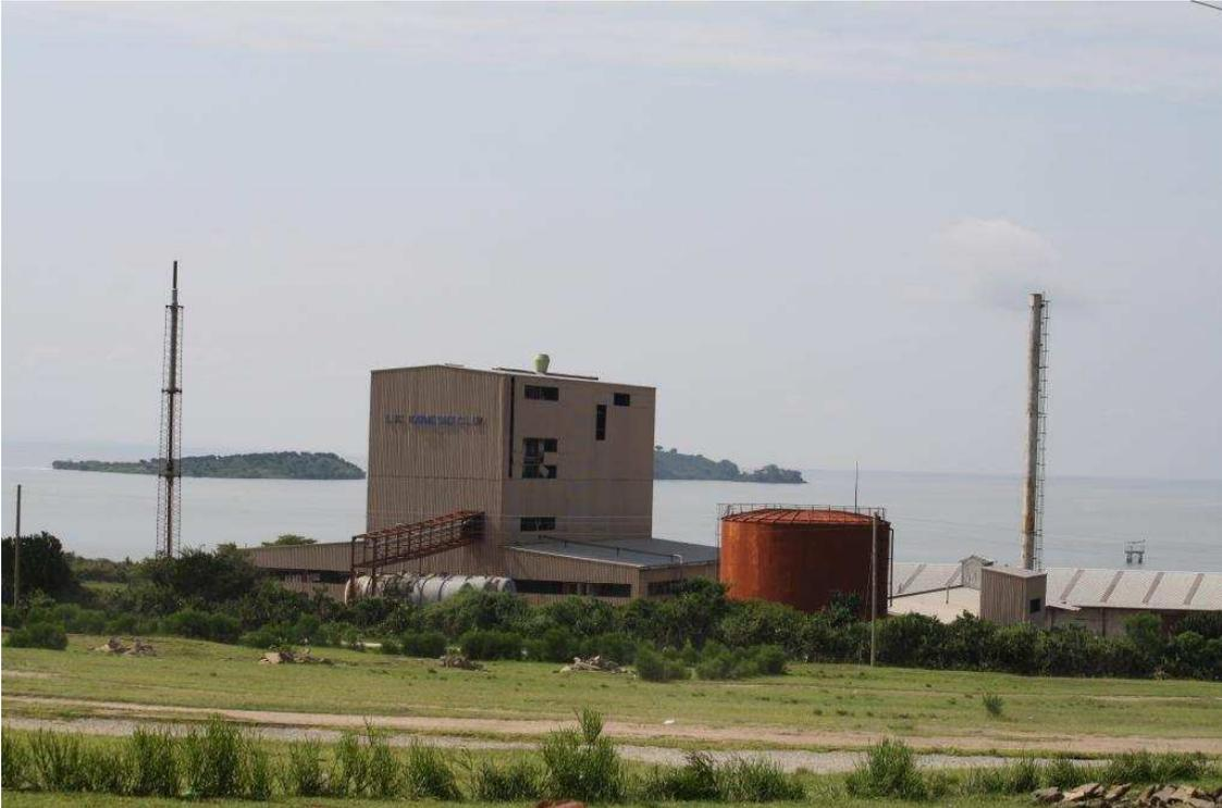
Diese Salzaufbereitungsanlage wurde von den Deutschen in den siebziger Jahren gebaut. Sie musste aber schon nach 6 Monaten aufgegeben werden, da die Maschinen wegen eines Konstruktionsfehler zu Rosten begannen. Jetzt wird ein Teil der Gebäude von der Firma benutzt, die im Lake Edward nach Öl sucht.
