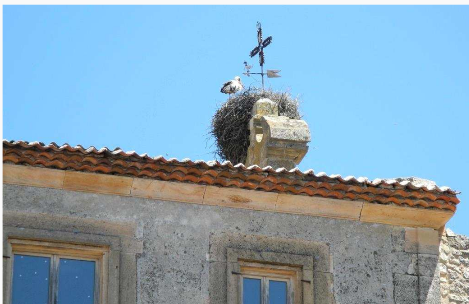
Auf den Gebäuden findet man immer wieder Storchennesterr
