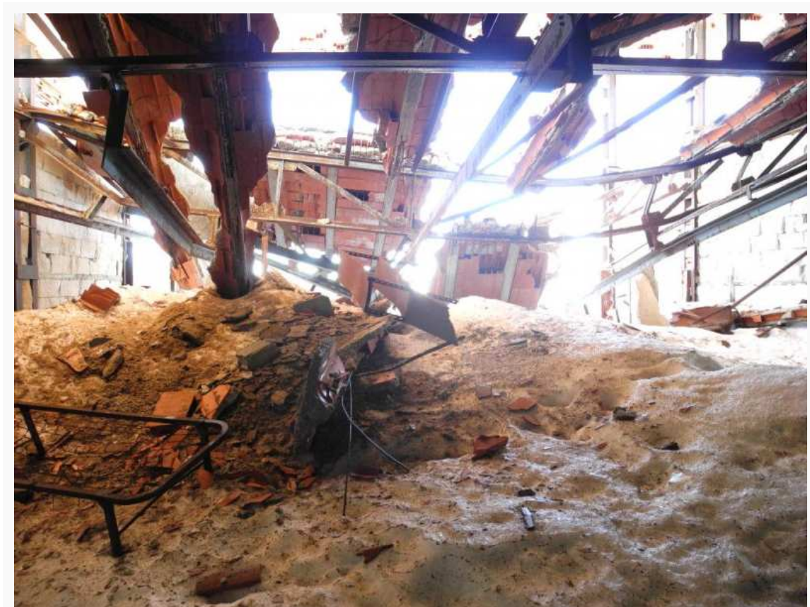
Das Skelett der Bahnstation
