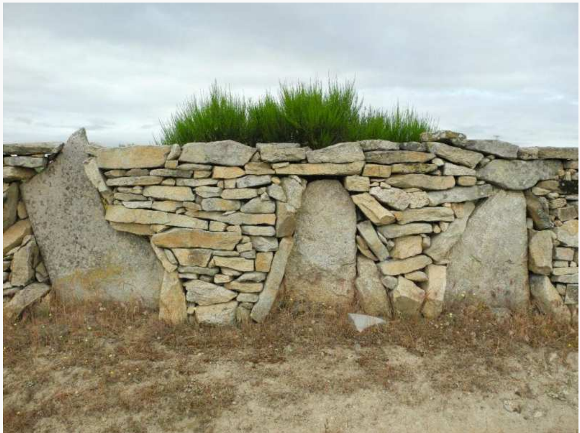
Beeindruckende Trockensteinmauern und ...
