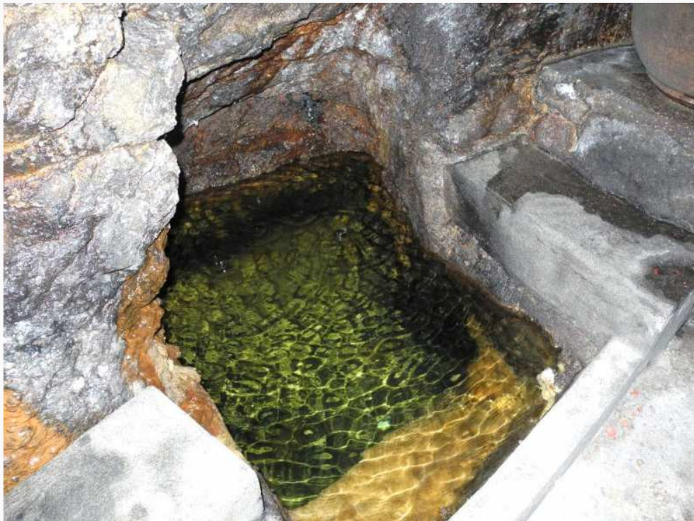
Unterirdische Quelle. Die ganzen Keller wurden vor Jahrhunderten aus dem Granitfelsen geschlagen
