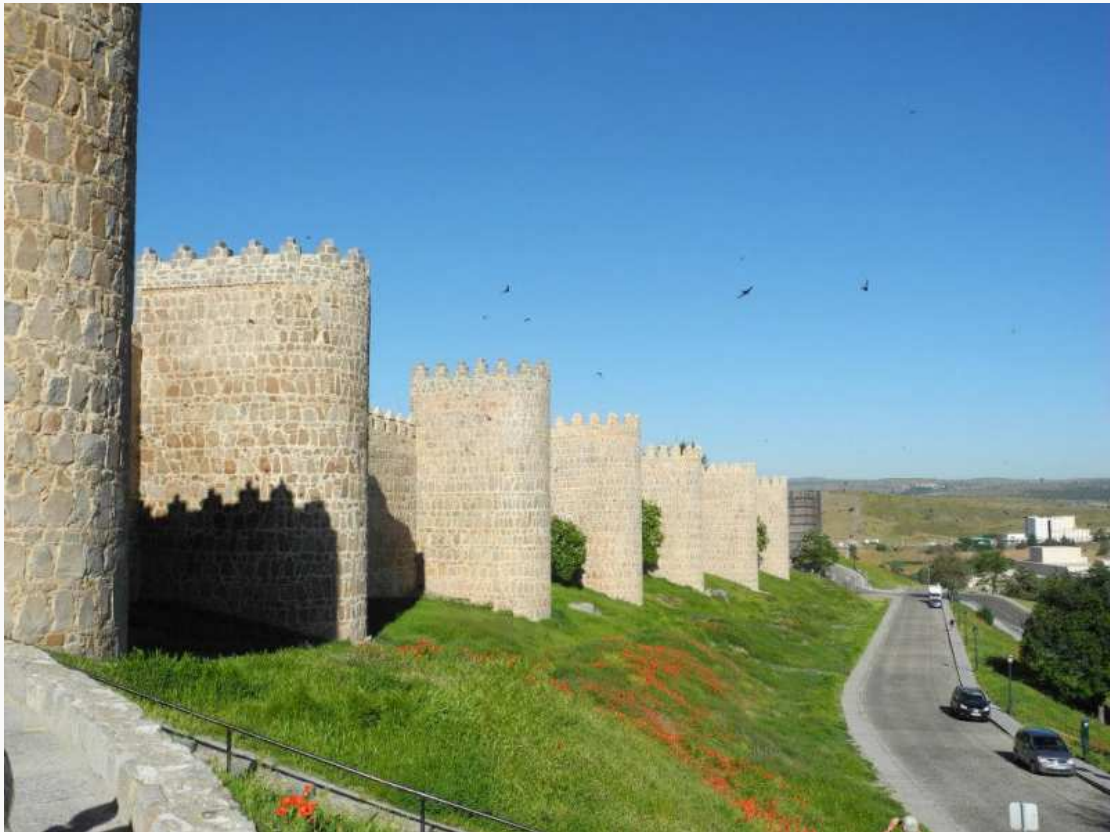
Die Stadtmauern rund um die Stadt gehören zu den besterhaltenen Europas. Sie haben eine Mauerdicke von 3 Metern
