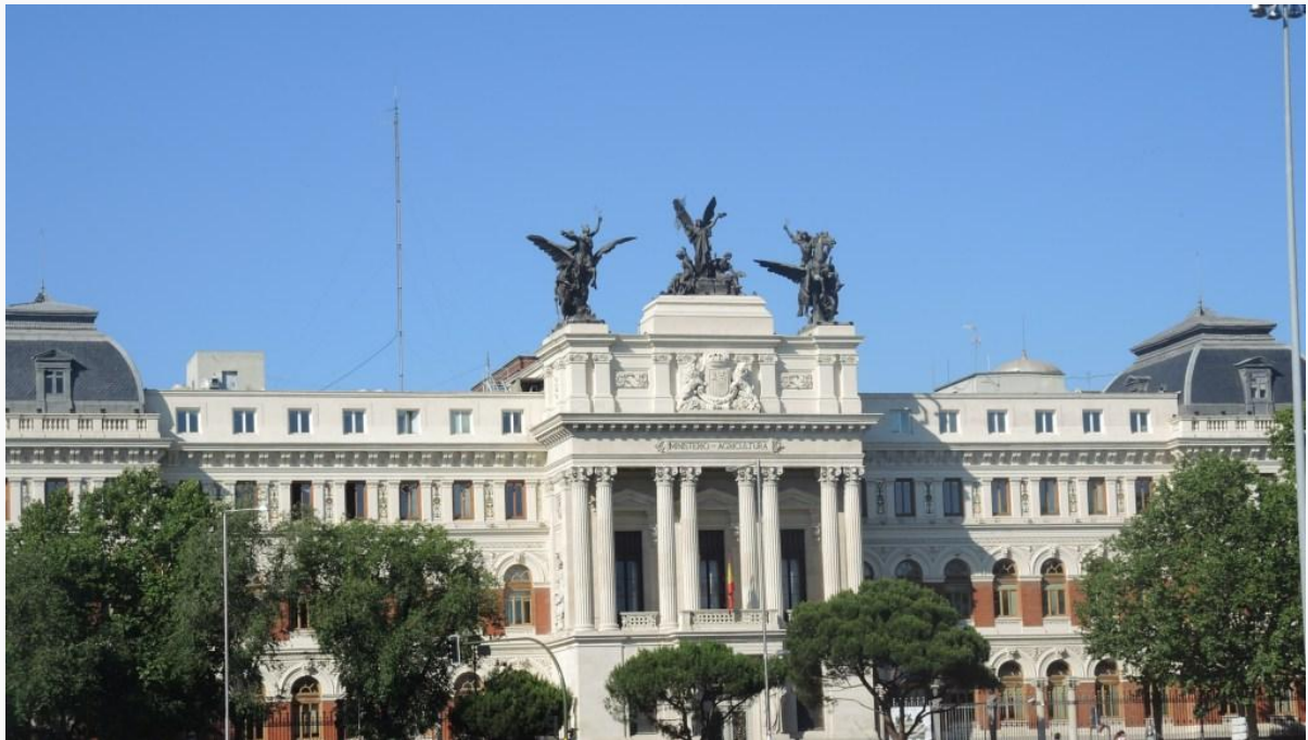
Neben dem Bahnhof steht das Gebäude des Ministerio de Agricultura
