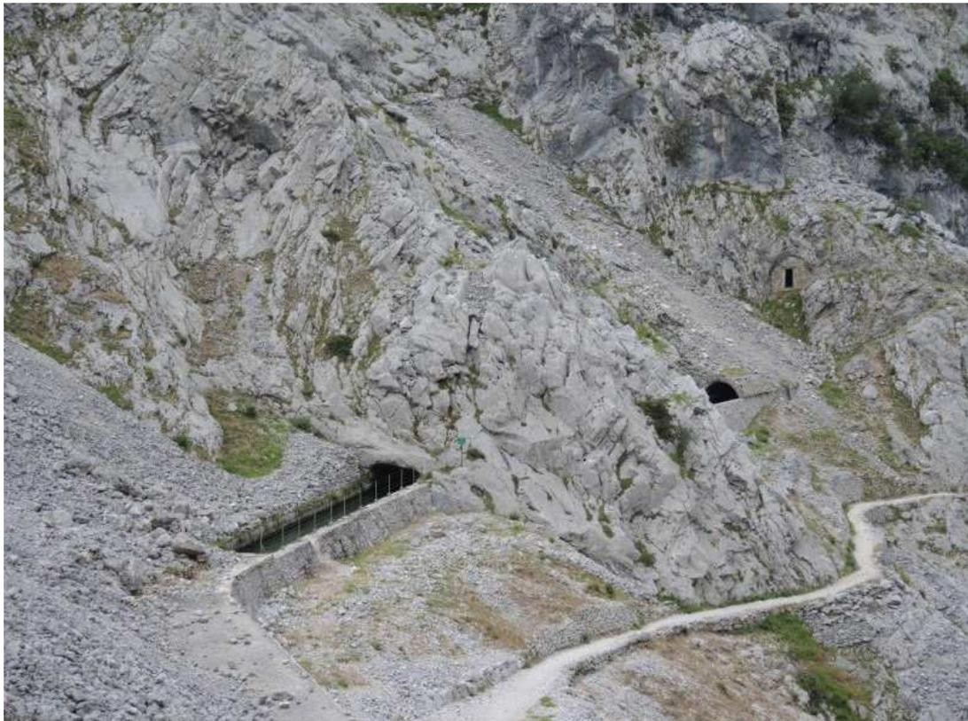
Zwischen 1915 und 1921 wurden die Arbeiten zur Fassung und Weiterleitung des Wassers des Rio Cares ausgeführt. Das Wasser betreibt die Central de Hidroeléctrica de Poncebos. Die Länge der Leitung beträgt 11 km mit 71 Tunneln. Mehr als 500 Arbeiter waren, beschäftigt
