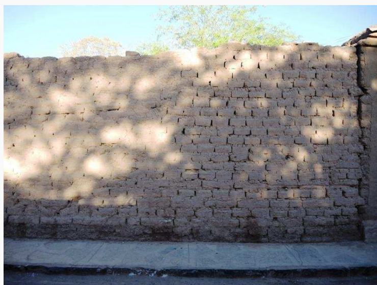
Wand aus Adobe-Ziegel. Diese Ziegel bestehen aus Lehm und Stroh und sind nicht gebrannt sondern getrocknet
