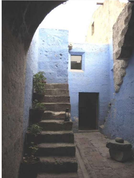
Aufgang zur Dachterrasse
