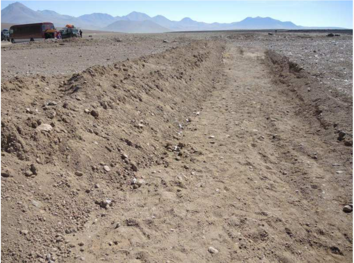
Von den einfachen Toiletten ist dies sicher die einfachste
