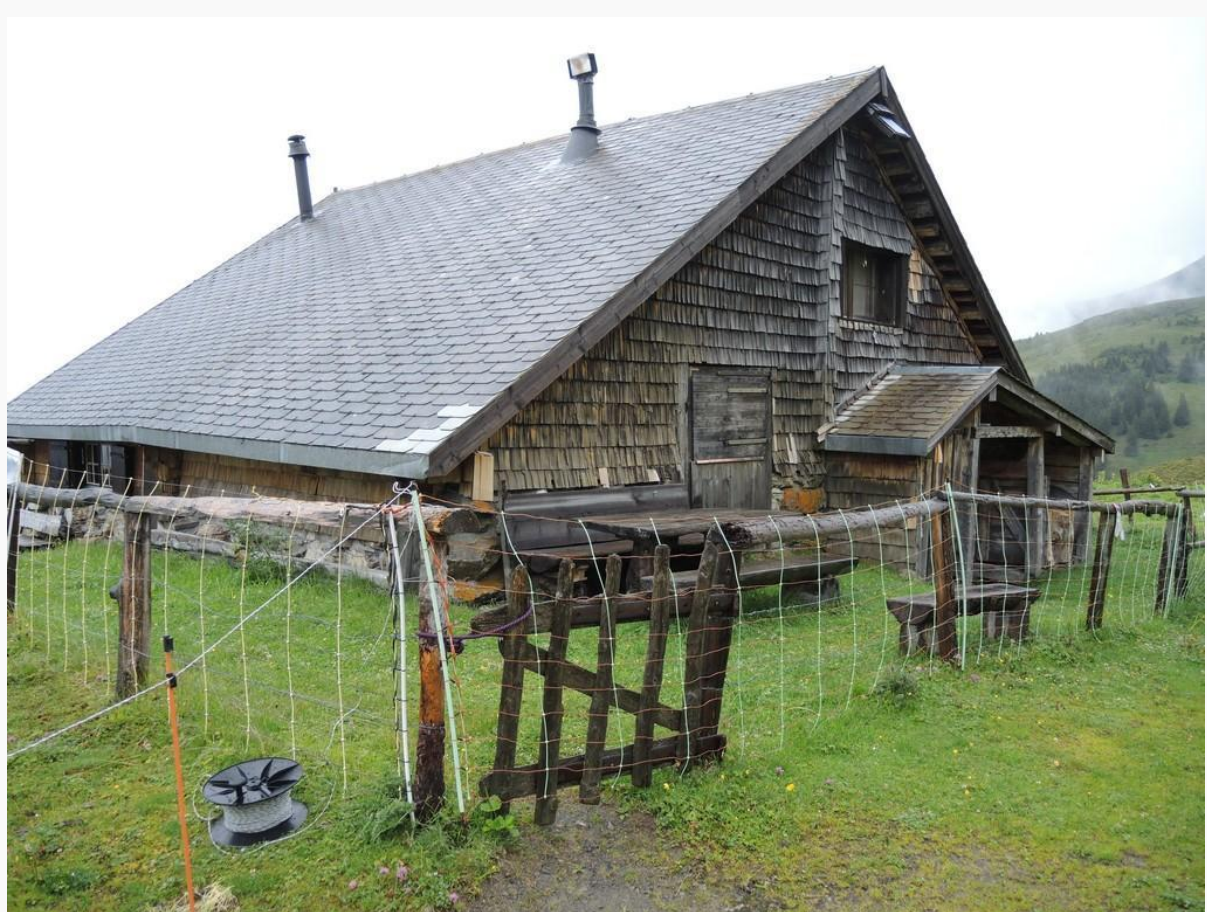
Das ist unsere Unterkunft: Das geschindelte Rota-Hus
