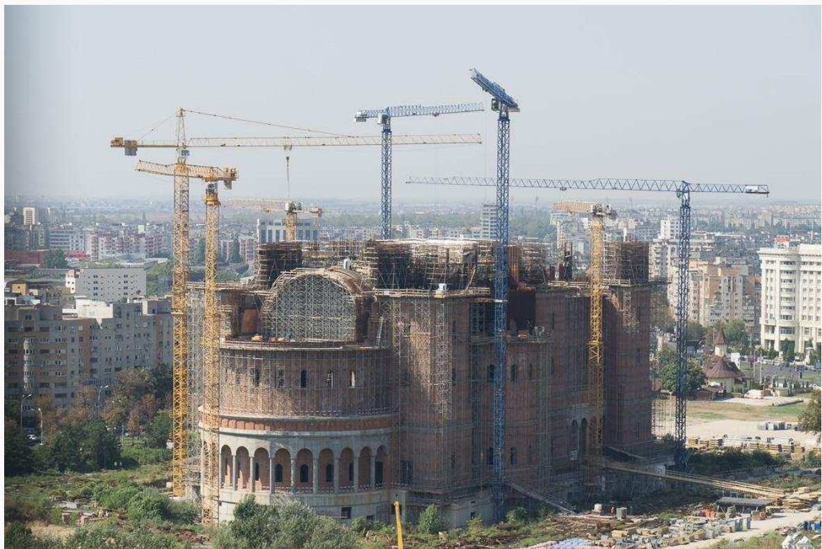
Neben dem Parlamentspalast wird eine neue rumänisch-orthodoxe Kirche gebaut deren Turm einmal den Palast überragen soll
