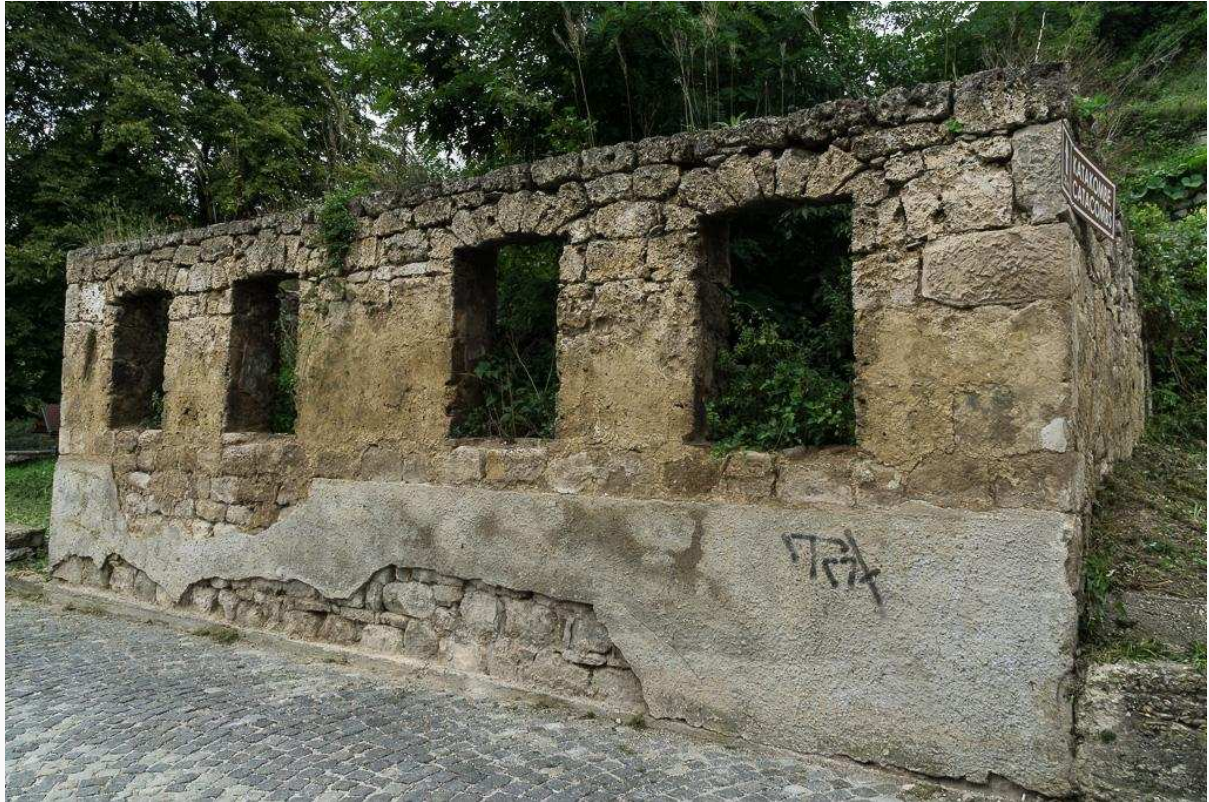
Überreste des Hauses Burica. Hier wurde 1943 die Sozialistische Föderative Republik Jugoslawien gegründet. Das Haus wurde 1992-95 zerstört.
