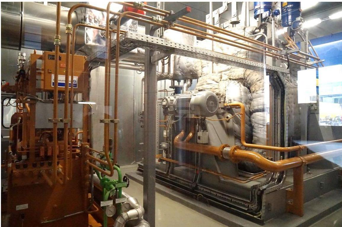
Verpackt die Dampfturbine, die den Generator dreht. Anschliessend wird der Dampf ins Fernwärmenetz eingespeist
