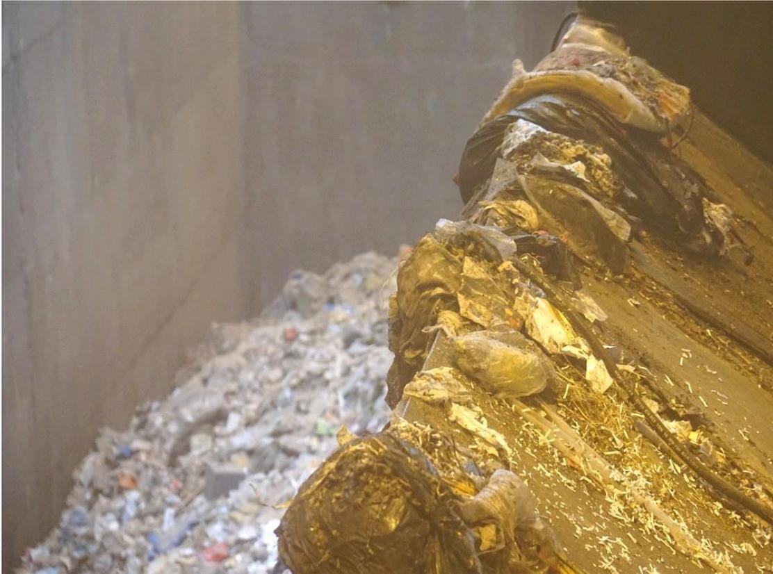
Der Bunker, das Rohstofflager, zur Zwischenlagerung des Abfalls. Hier können 15 000m<sup>3</sup> resp. 6 000 Tonnen Abfall gelagert werden. Der Bunker ist hermetisch abgeschlossen, hier drin soll es grauenhaft stinken...
