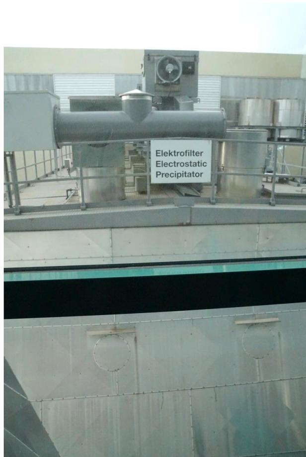
Gigantischer Elektrofilter. Hier drin stehen Metallplatten, die mit Hochspannung elektrostatisch aufgeladen werden. Das zieht die Flugasche an und sie kann dann periodisch abgeklopft werden
