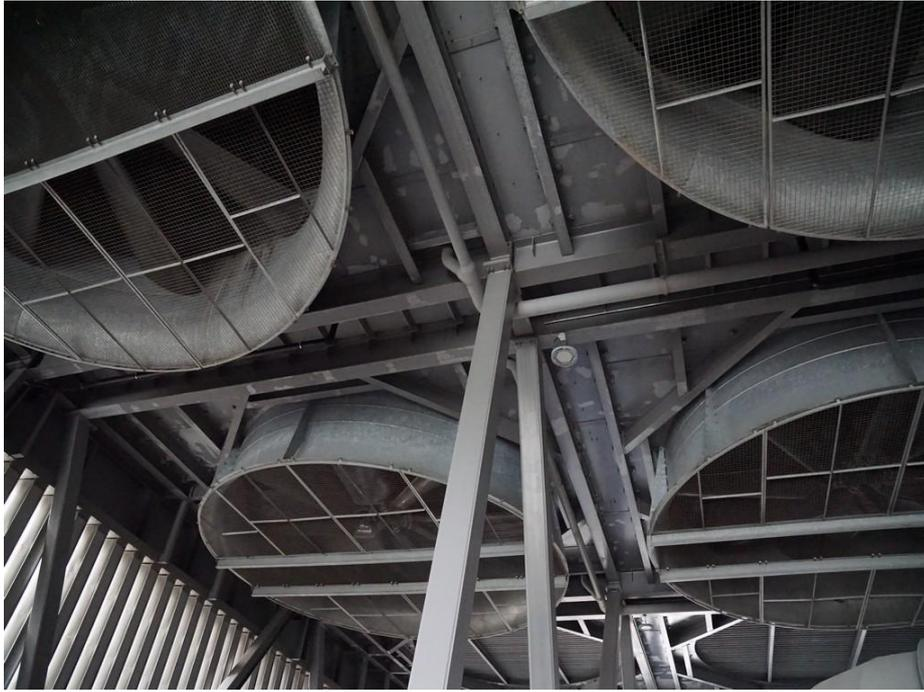
Ventilatoren zur Kühlung der Kondensatoren im Sommer
