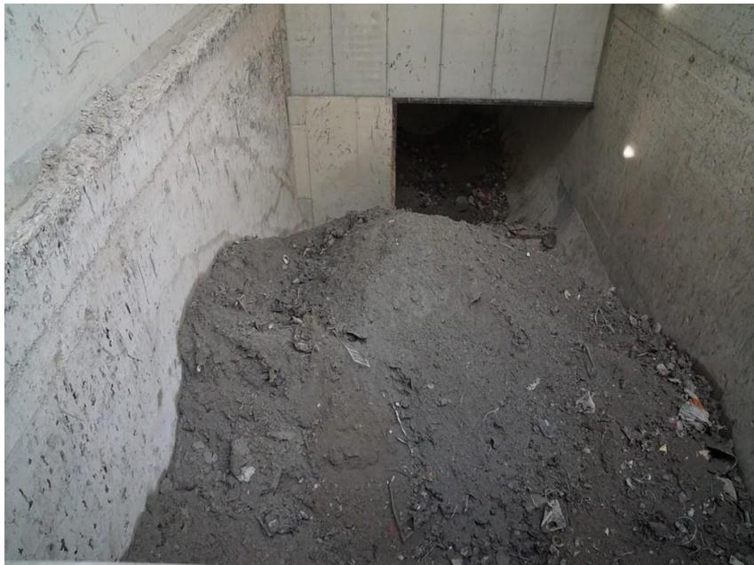
Schlackenbunker. Es fallen pro Jahr 52 000 Tonnen Schlacke an. Darin sind 6 000 Tonnen Metalle enthalten. Davon sind 4 000 Tonnen gröbere Teile, die mit Sieben herausortiert werden können. Die restlichen 2 000 Tonnen, teils hochwertige Metalle, können in Zukunft mit aufwendigeren Verfahren auch zurückgewonnen werden. Die Schlacke wird extern weiterverarbeitet und deponiegerecht aufbereitet
