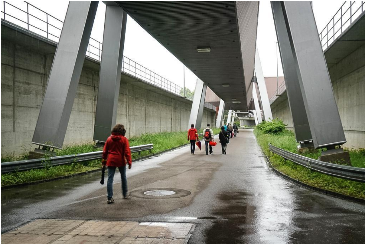
Oben im Hochkanal führen die Verbindungsleitungen zwischen den Klärbecken durch
