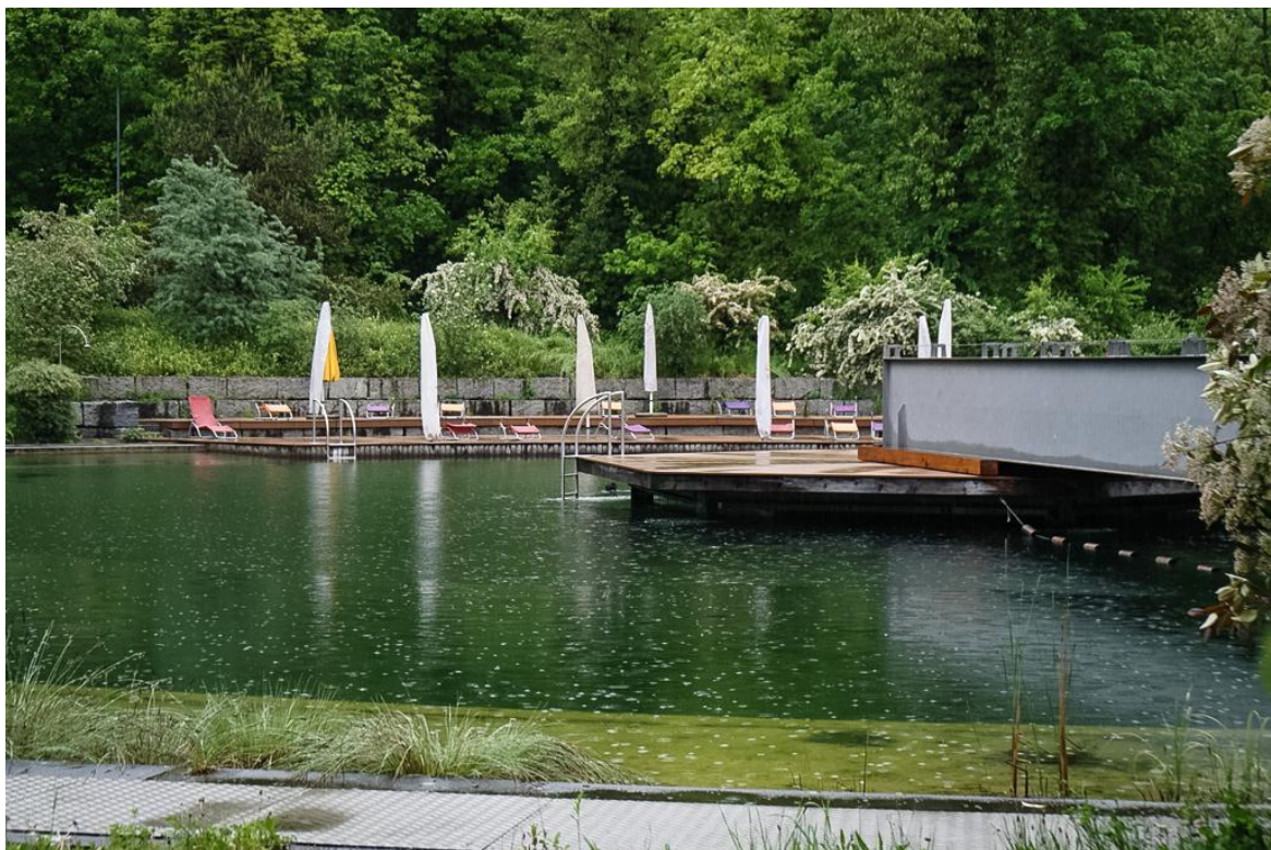
Stillgelegtes Klärbecken. Wird jetzt als Naherholungsteich benützt
