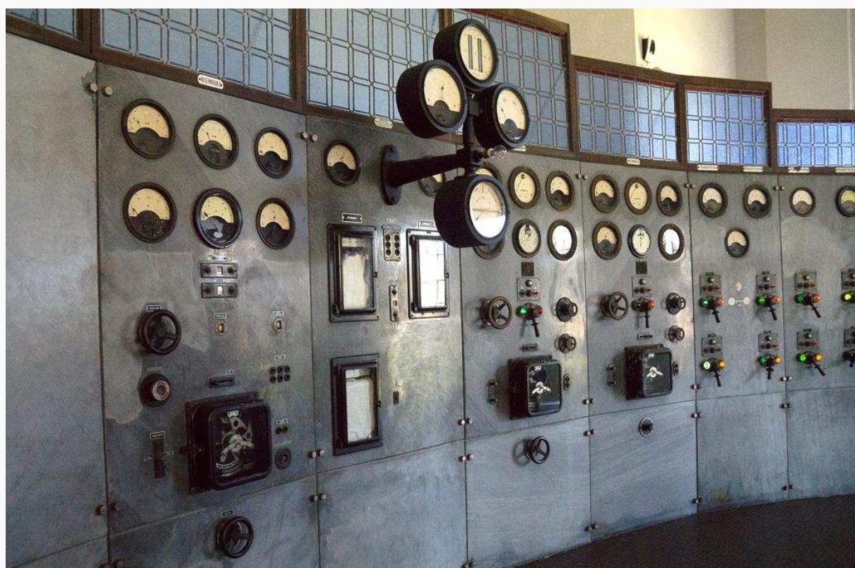
Bedienwarte. Die Instrumente sind auf Marmortafeln montiert
