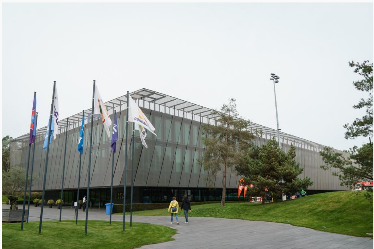
Ein Stahlnetz umspannt das Gebäude. Es soll eine Reminiszenz an das Netz eines Fussballtores sein
