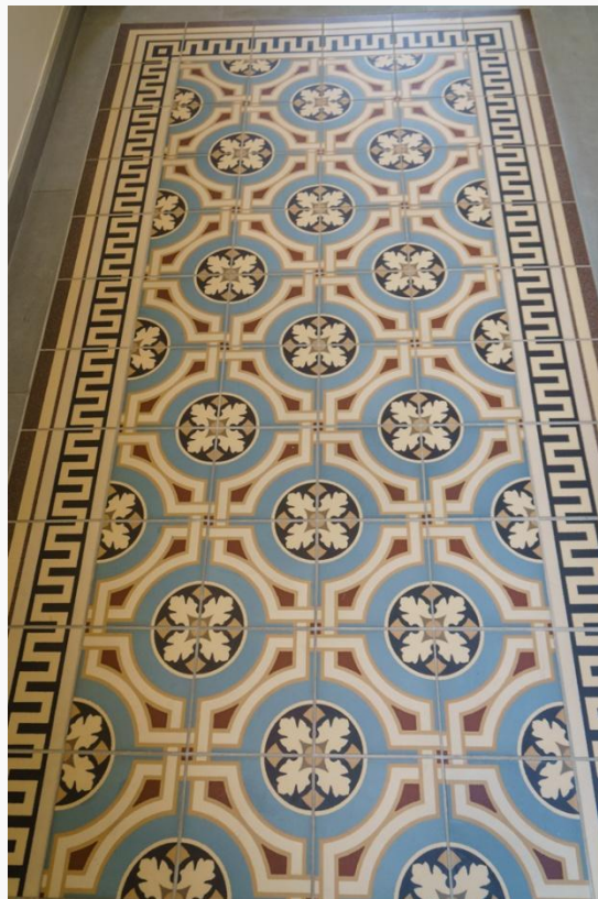
Die Böden wurden im Originaldesign mit neuen Materialien hergestellt
