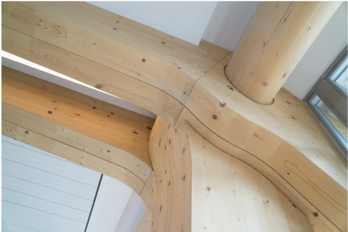
Verbindungen ohne Metallteile
