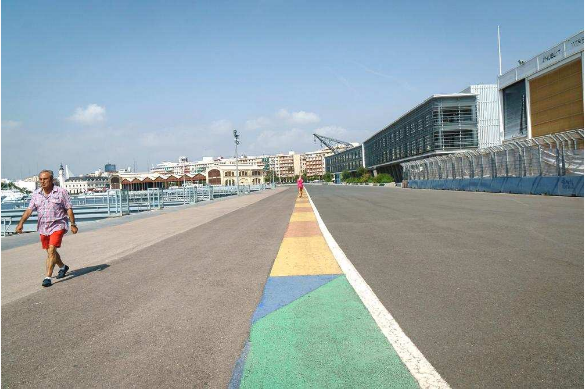
Um den Hafen wurde auch der Grosse Preis von Europa in der Formel 1 ausgetragen, jetzt liegt die nur einmal benutzte Anlage brach
