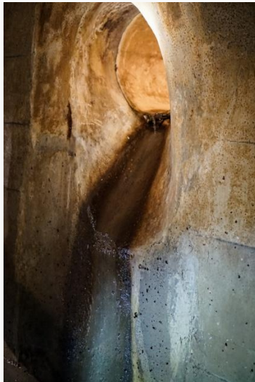
Anschluss des Schwimmbad Letzi
