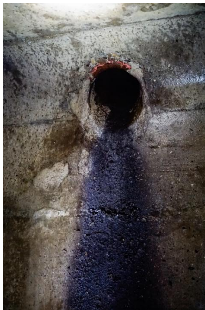
Anschluss eines Strassenschachtes
