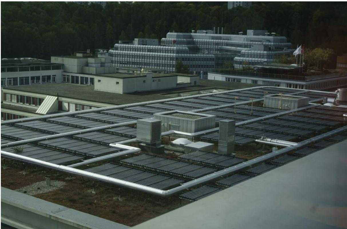
Solaranlage. Deren Wärme wird im Sommer zum Kühlen gebraucht und im Winter zum Heizen
