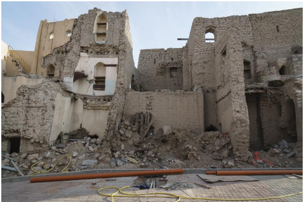
In Nizwa werden die Lehmbauten mit Hilfe von marokkanischen Architekten aufwendig renoviert
