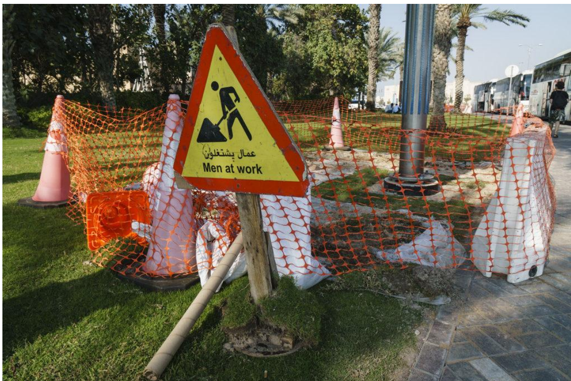
Mitten im Leben sind wir von Baustellen umgeben
