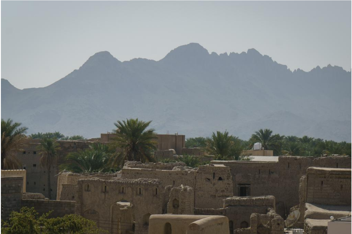
Lehmbauten in Nizwa
