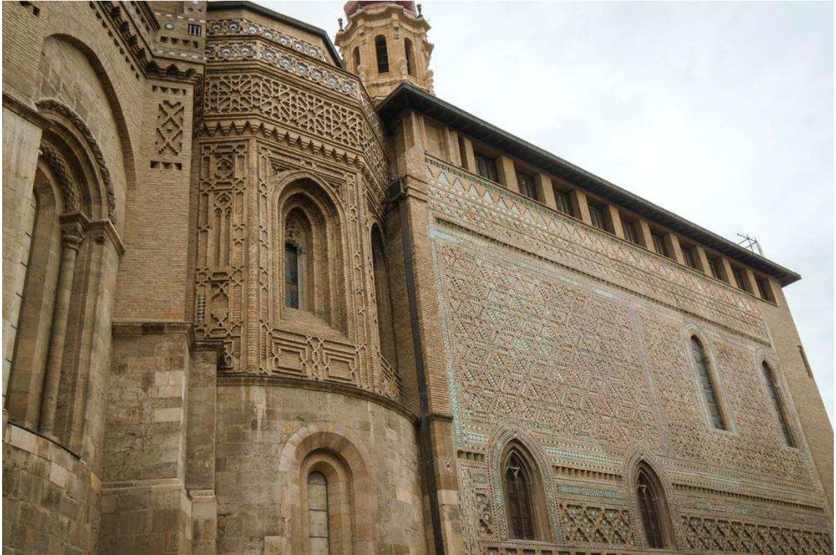
Maurischer Anbau der Basilika
