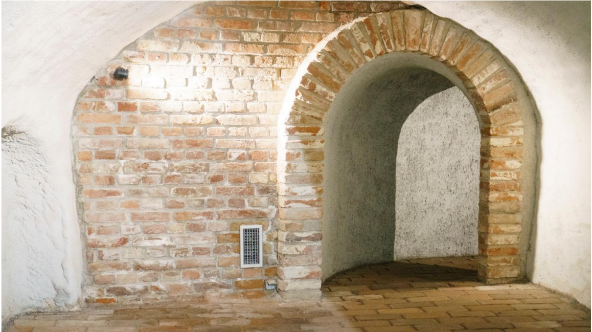
Unter dem Krautmarkt befinden sich mittelalterliche Gänge und Keller.
