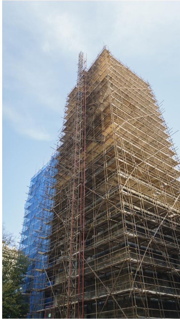
Die Moritzkirche ist gerade eine Baustelle
