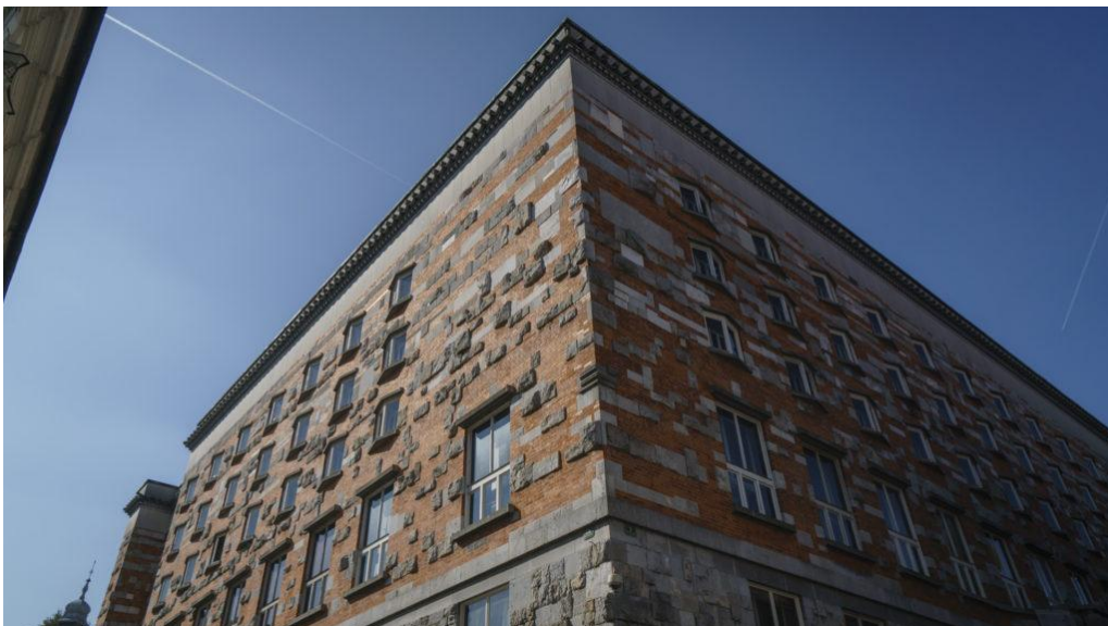
Die Bibliothek, vom berühmten Architekten Jože Plečnic 1941 fertiggestellt
