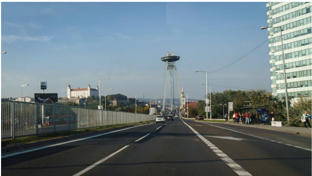
Über die neue Brücke mit der UFO-Aussichtsplattform.
