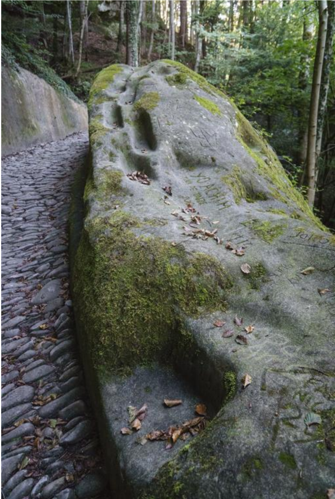
Torenöli: In Sandstein gehauener und mit Flusskieselsteinen belegter Fahrweg mit den Trittspuren der Fuhrwerker.
