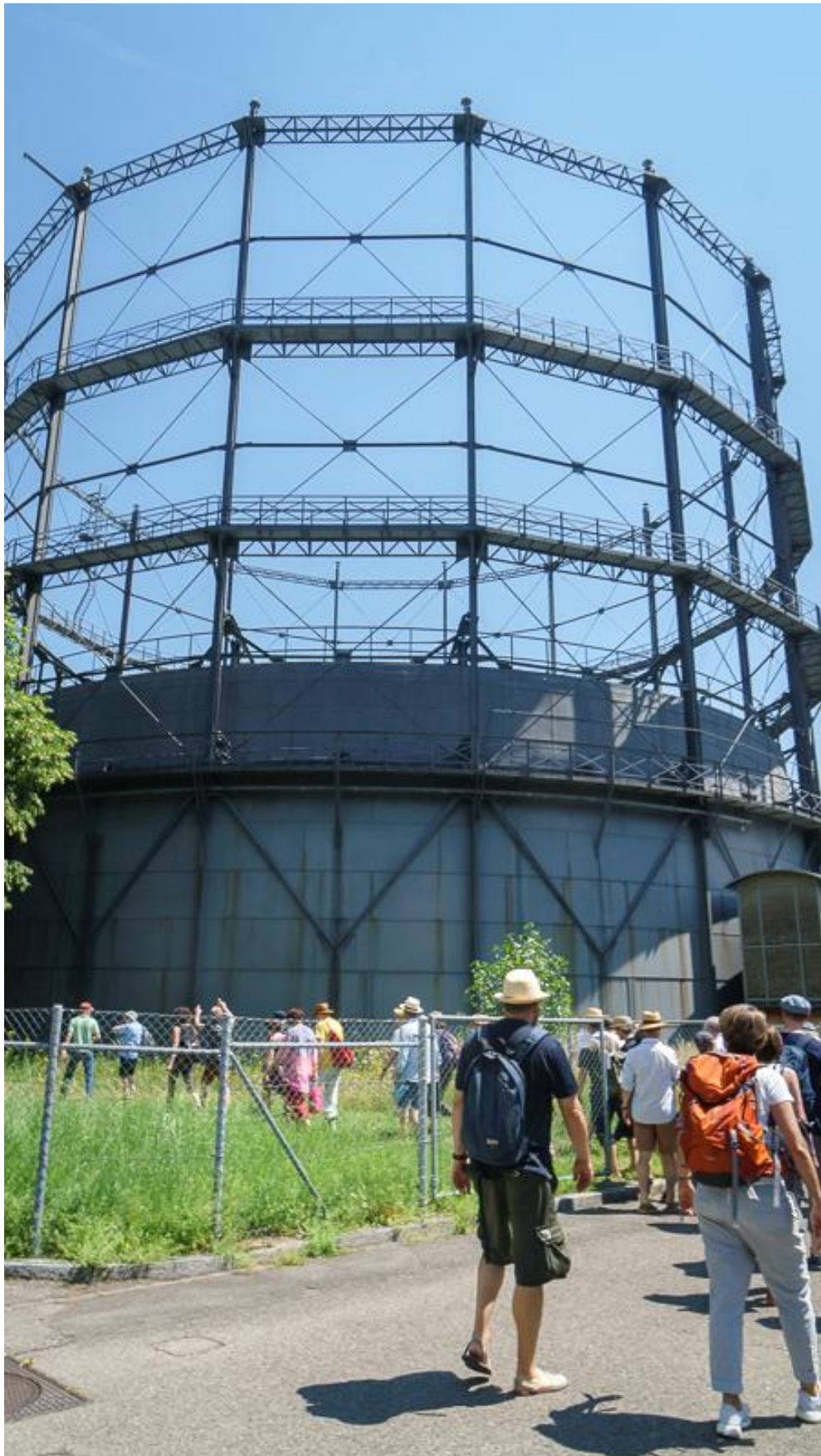
Gasometer als temporäre Lagerstätte des Gases
