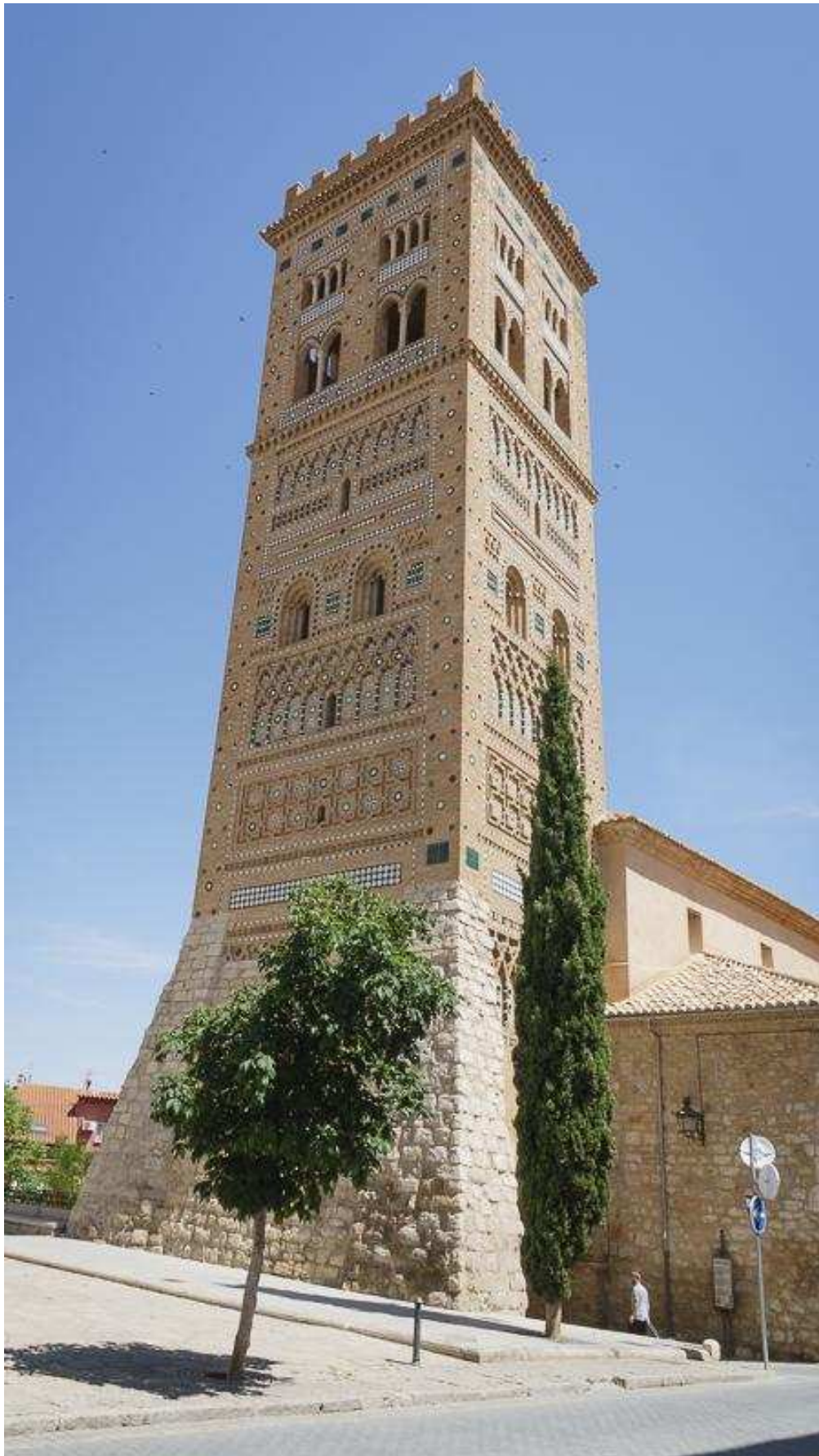
Der Turm San Martín, einer der vier Türme im Mudéjar-Stil
