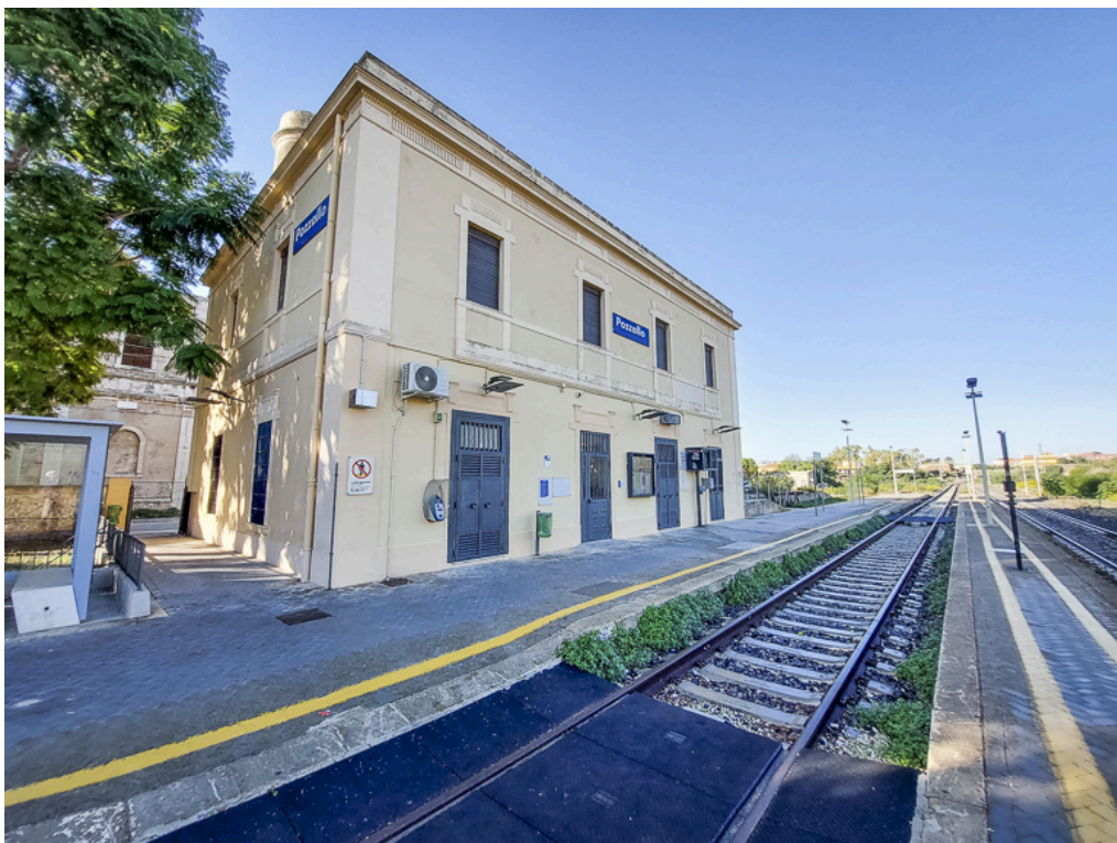
Europas südlichster Bahnhof mit Personenverkehr. Ein Zug kommt gerade nicht, Probleme an den Geleisen.
