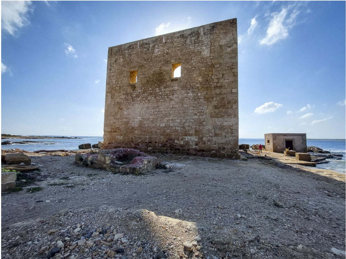
Der Torre di Vendicari aus dem 15. Jahrhundert diente erst als Lagerhaus, dann als Wachturm und zuletzt als Leuchtturm.
