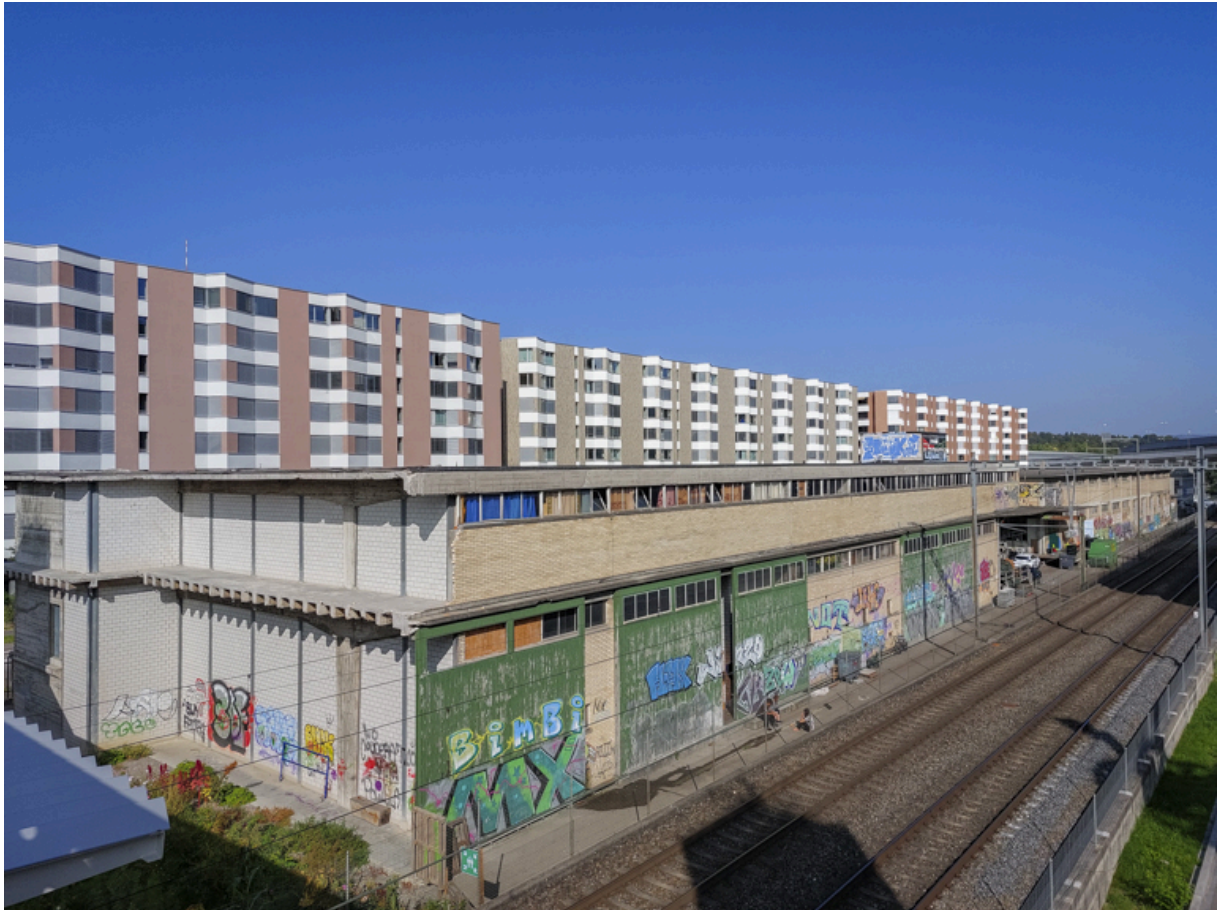
Diese ehemaligen Lagerhäuser werden abgerissen.
