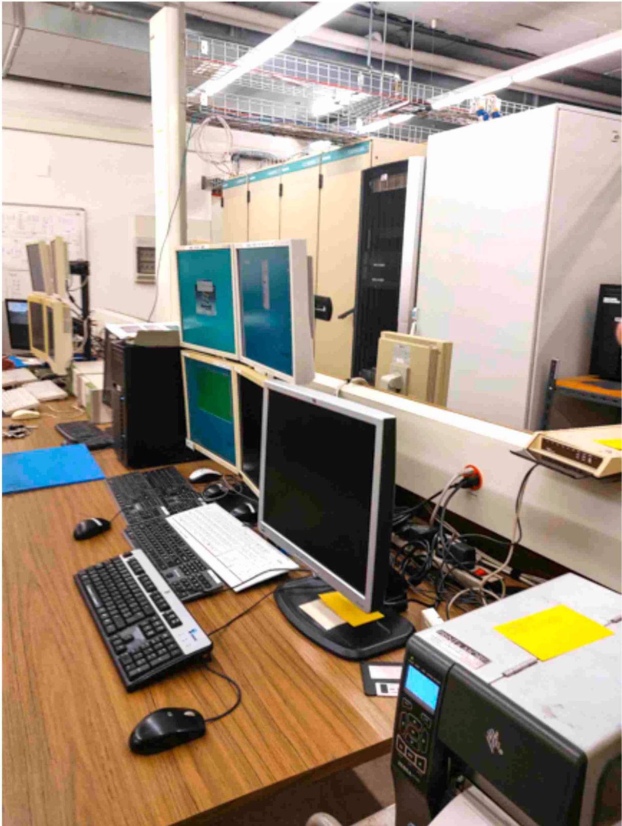
Momentan wird die Steuerung modernisiert
