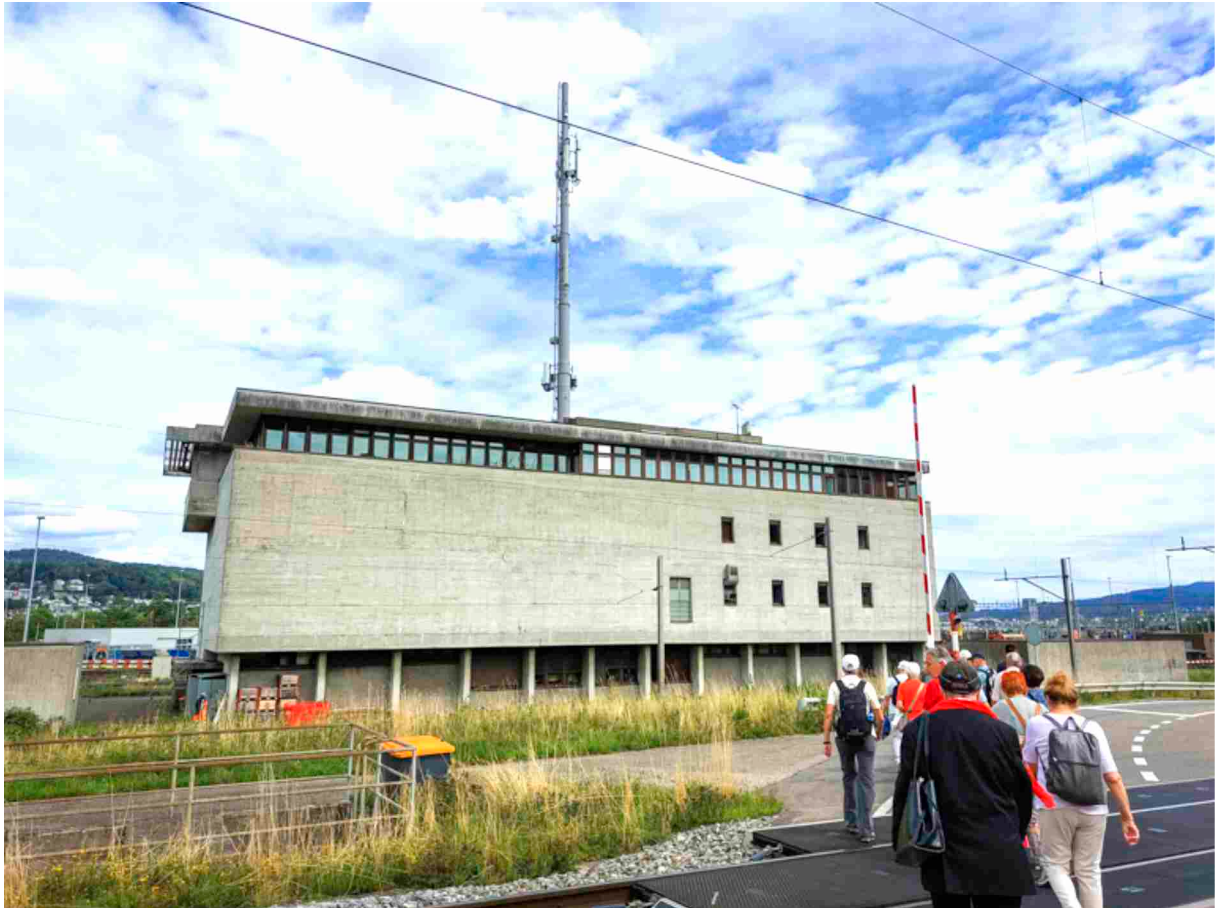
Gebäude der Stellwerks
