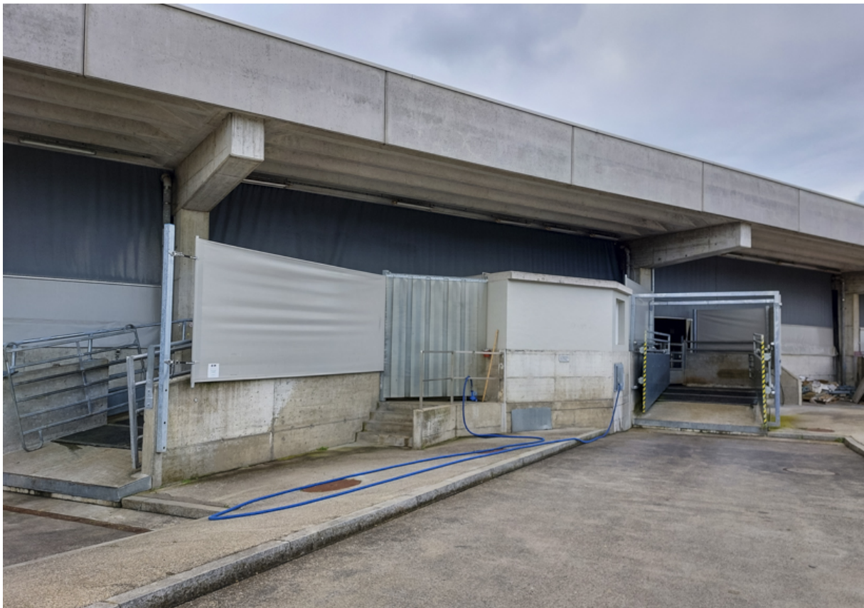
Hier werden die Schlachttiere angeliefert.
