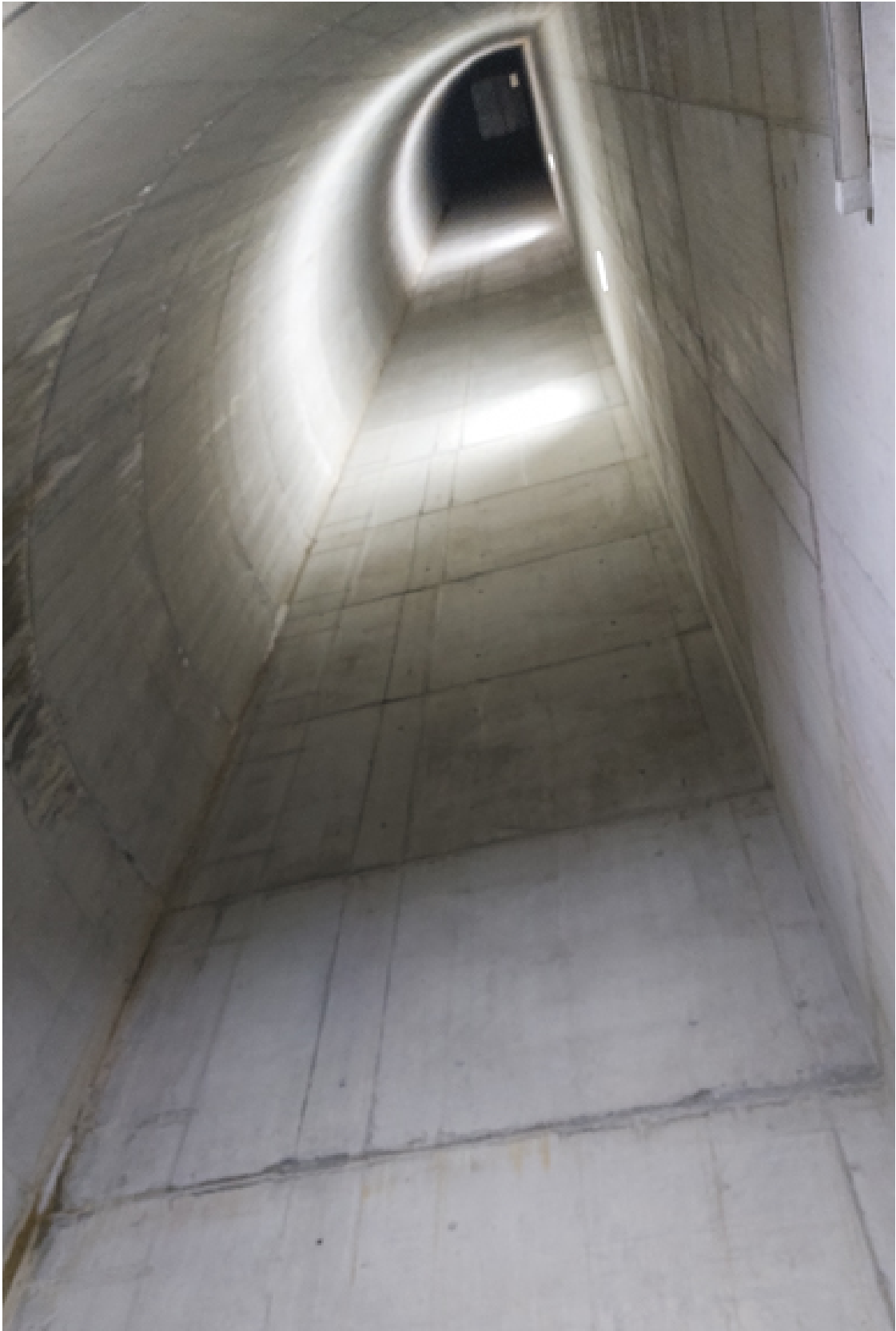
Zubringerschacht zum Stollen
