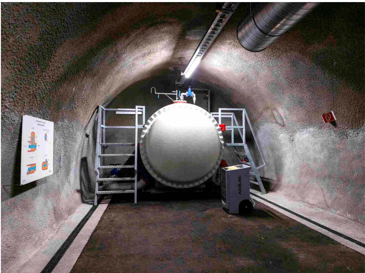
Für Reinigungs- und Kontrollzwecke kann dieser Abschlussteil der Leitung geöffnet werden.
