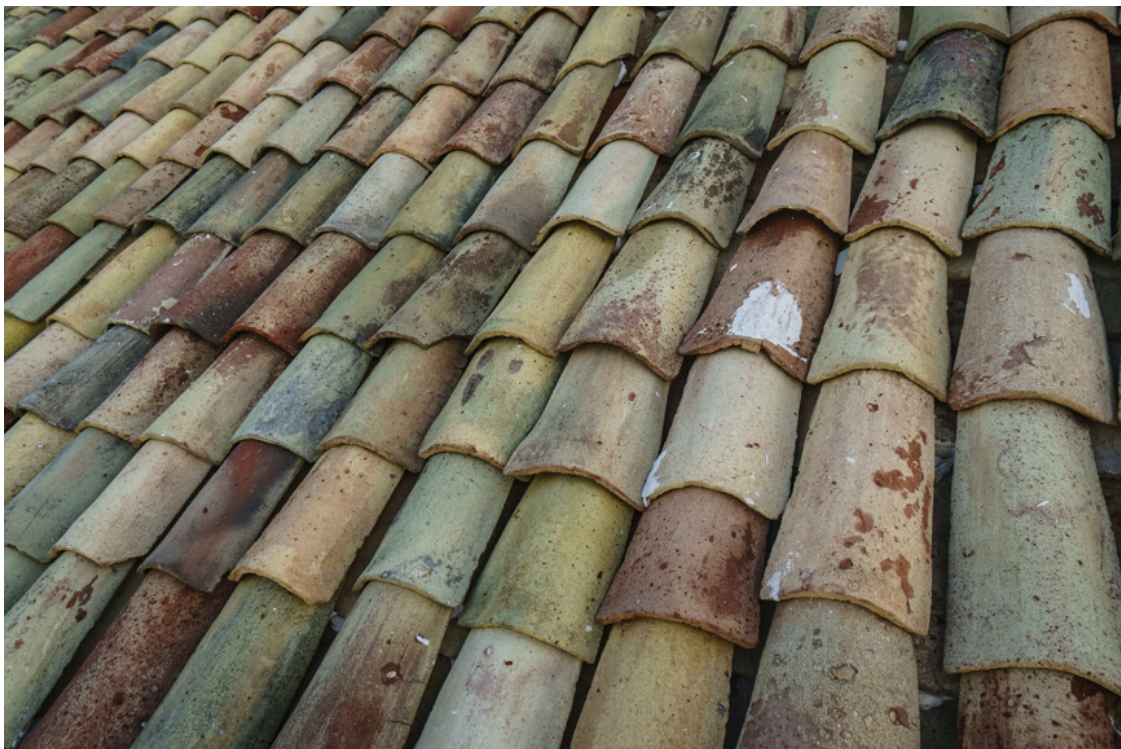
Die Tonziegel werden auf dem Oberschenkel des Arbeiters modelliert. Sie sind darum unregelmässig geformt
