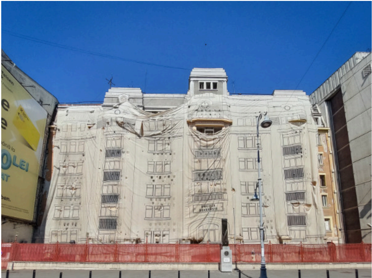
Das Polizeigebäude bekommt ein neues Kleid
