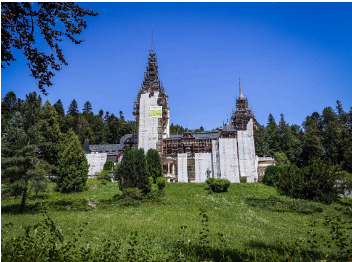
Schloss von Carol I. Im Renovationskleid. Das „Neuschwanstein der Karpaten“
