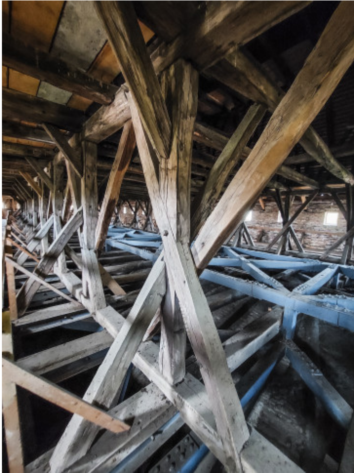
Dachstuhl der Kirche. Alles aus Holz
