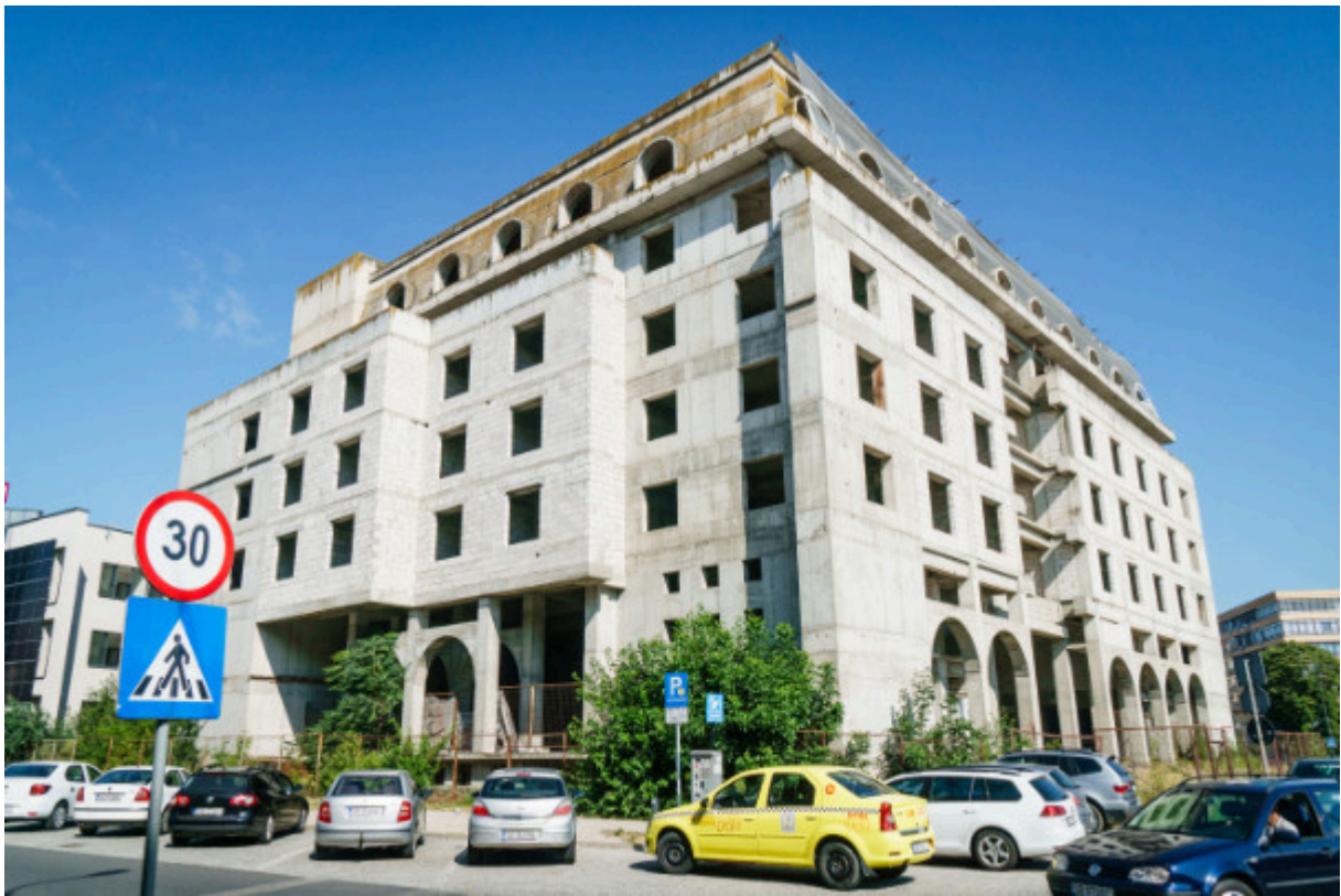
Bauruine (vermutlich ist den Investoren das Geld ausgegangen, bevor der Bau fertig war...)
