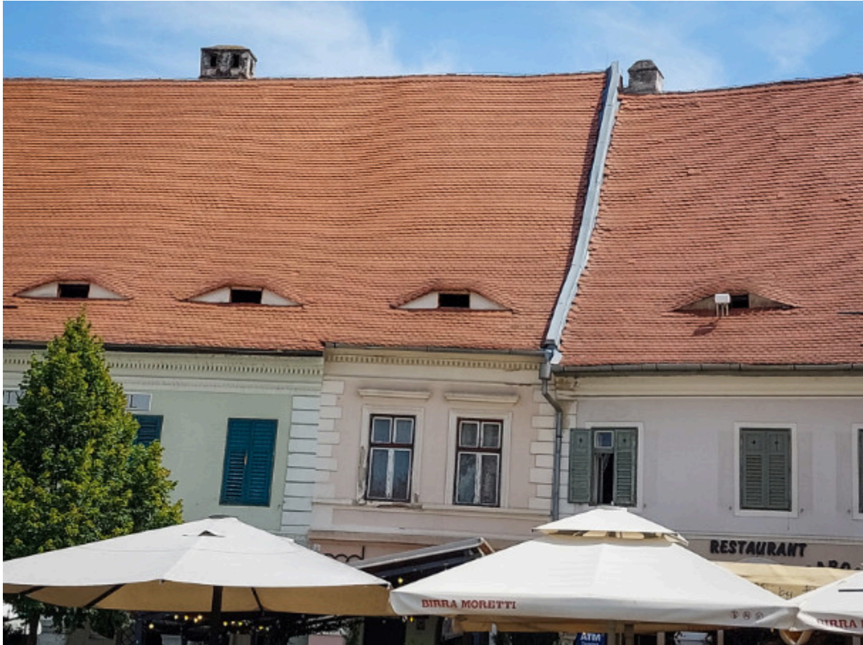
Die Augen von Sibiu. Es sind Lüftungsschlitze für die im Dachgeschoss gelagerten Vorräte
