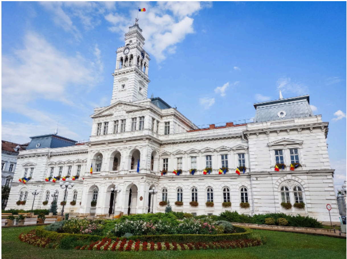
Rathaus. Die Turmuhr wurde 1872 aus der Schweiz gebracht.
