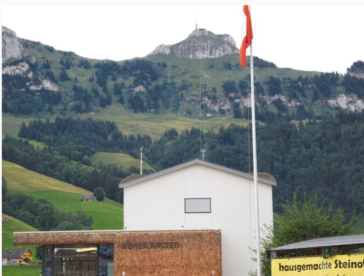
In Brülisau steht die Talstation der Hohen Kasten-Bahn
