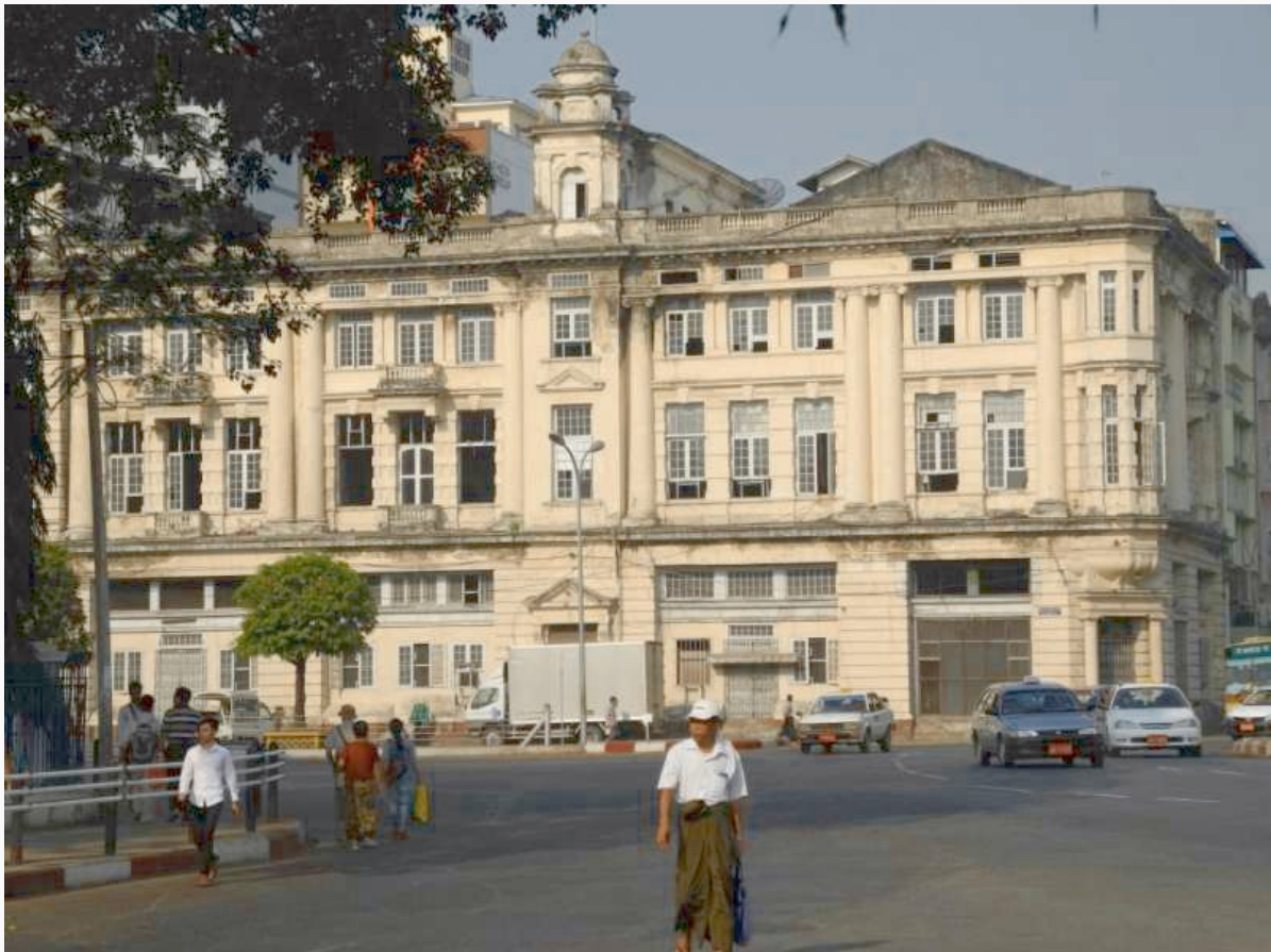
Ehemaliges Tourismusministerium. In Yangon gibt es viele Gebäude aus der Kolonialzeit
