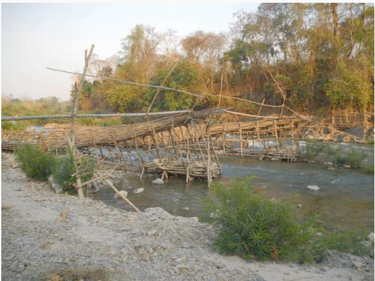
Fischfallen für den Hochwasserbetrieb
