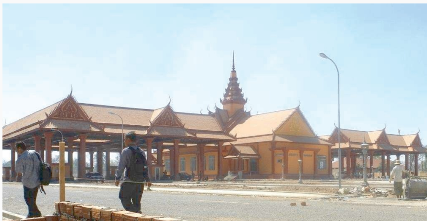
Der kambodschanische Grenzposten (im Bau)
