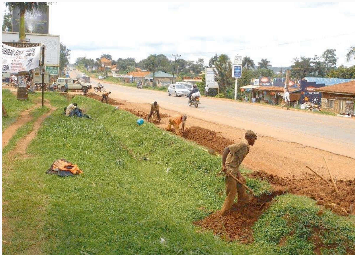
Arbeiten an der Strasse nach Entebbe
