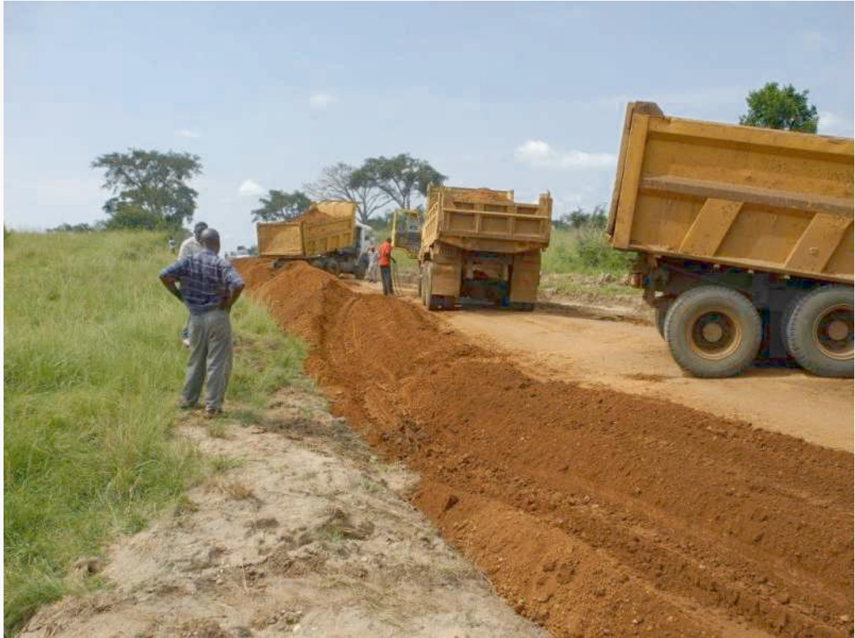
Die Strassen werden instandgehalten. Eine grosse Aufgabe bei diesem riesigen Strassennetz
