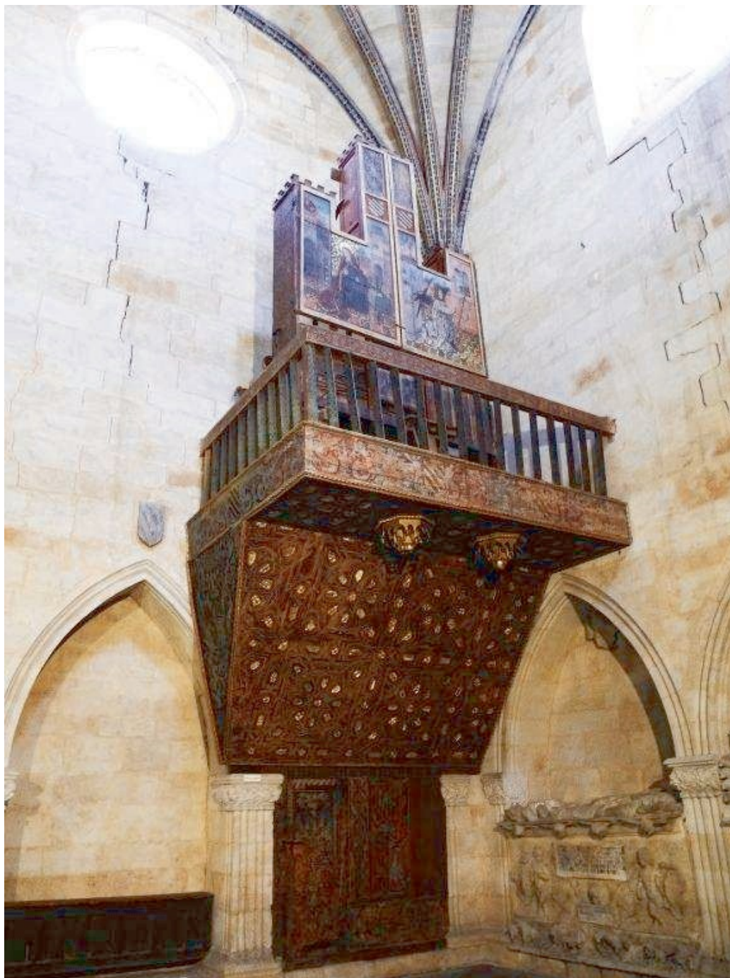
Die zweiälteste Orgel Europas. Die älteste steht in Sion (VS). Links und rechts Risse, die vom Erdbeben von 1755 stammen. Dieses Erdbeben hat u.a. Lissabon zerstört
