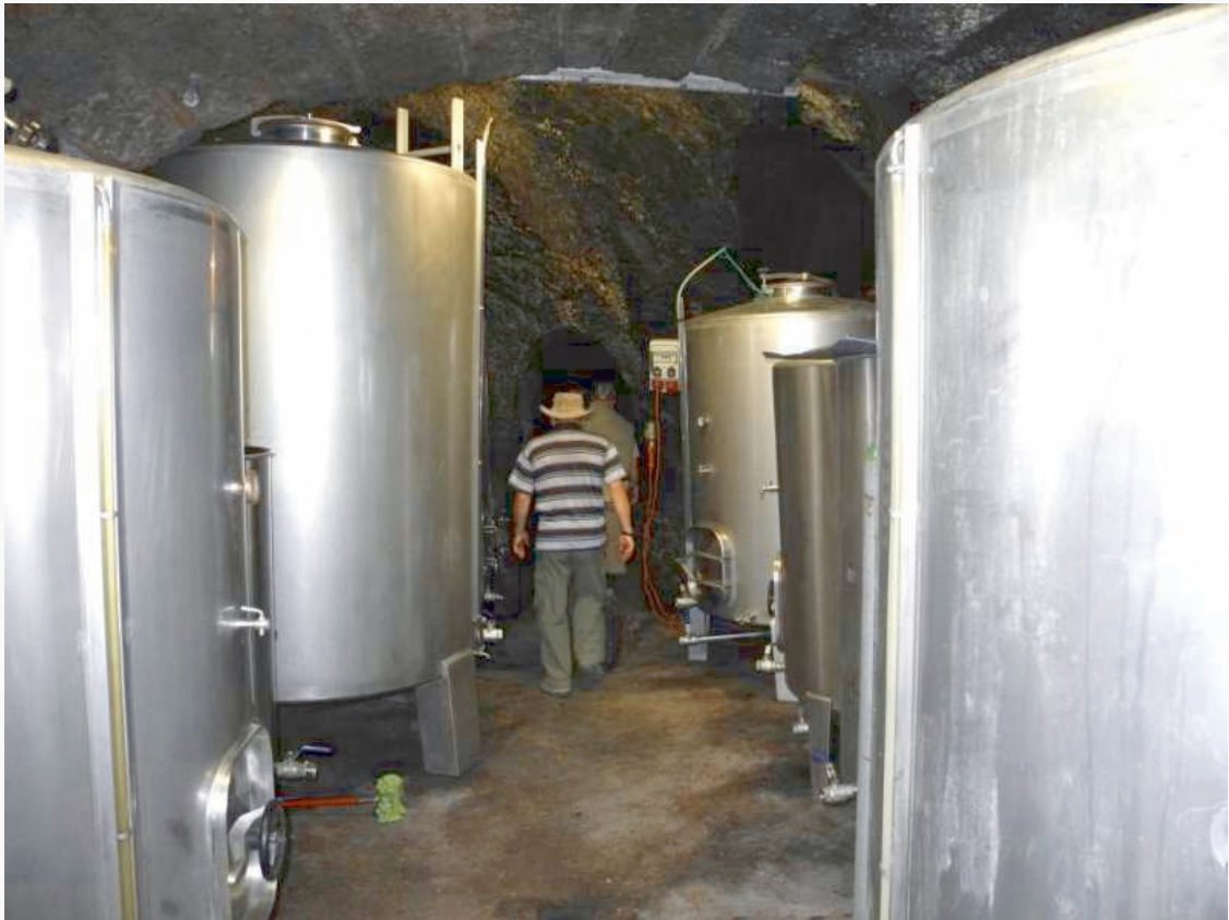
Die Stahltanks dienen zum Endausbau und Assemblierung der Weine
