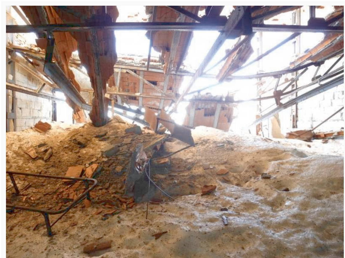
Das Skelett der Bahnstation
