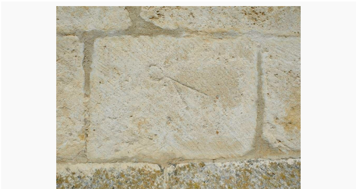
Die mittelalterlichen Steinmetze haben auf den Steinblöcken ihre Zeichen hinterlassen. Diese Zeichen wurden gezählt und die Handwerker entsprechend entlohnt
