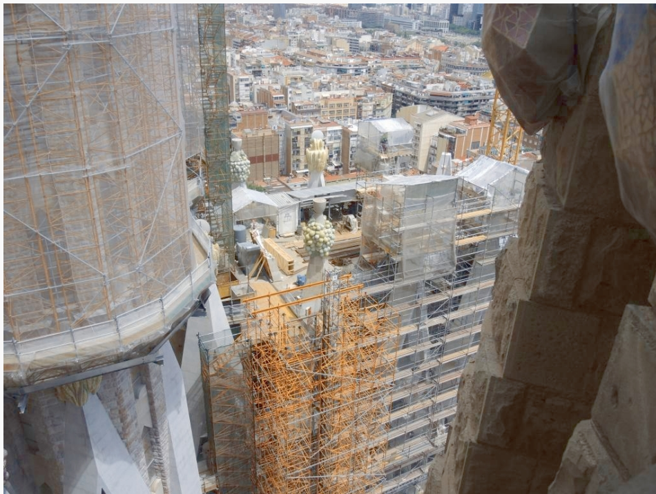
Bauplatz auf luftiger Höhe
