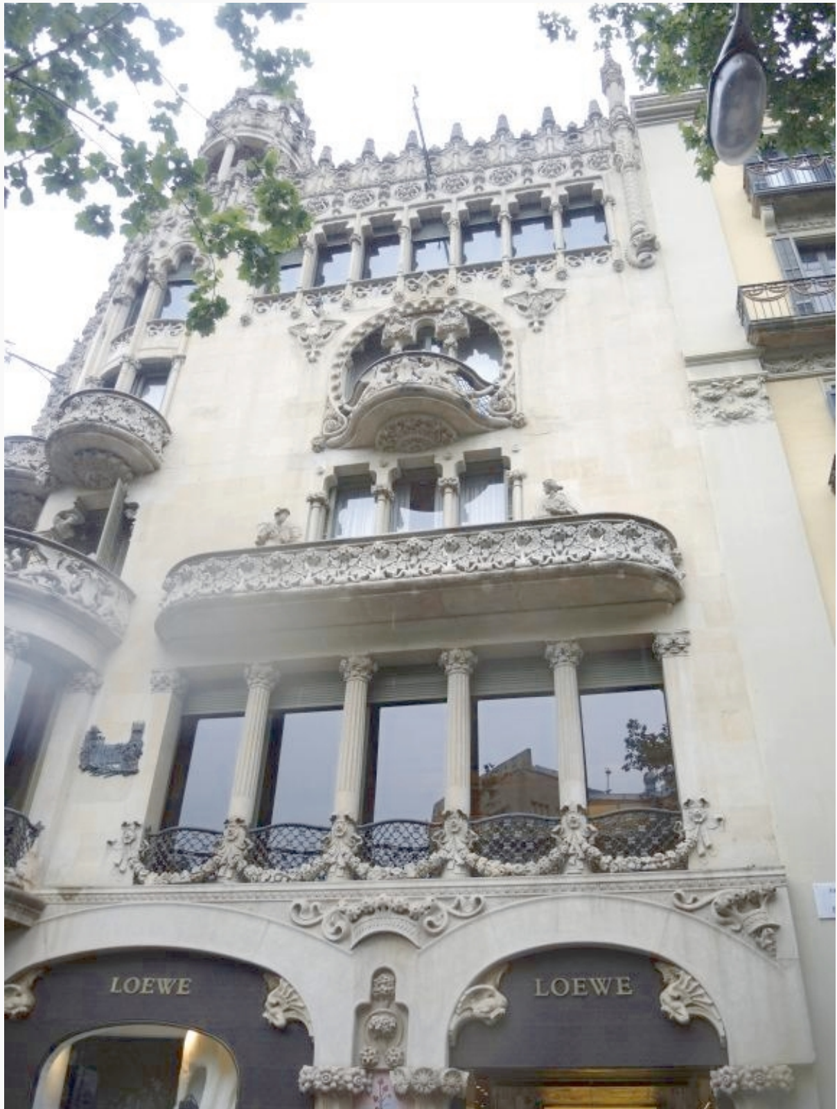
Zwei Häuser weiter dann das Casa Lleó Morera von Lluís Domènech i Montaner, 1905 fertiggestellt
