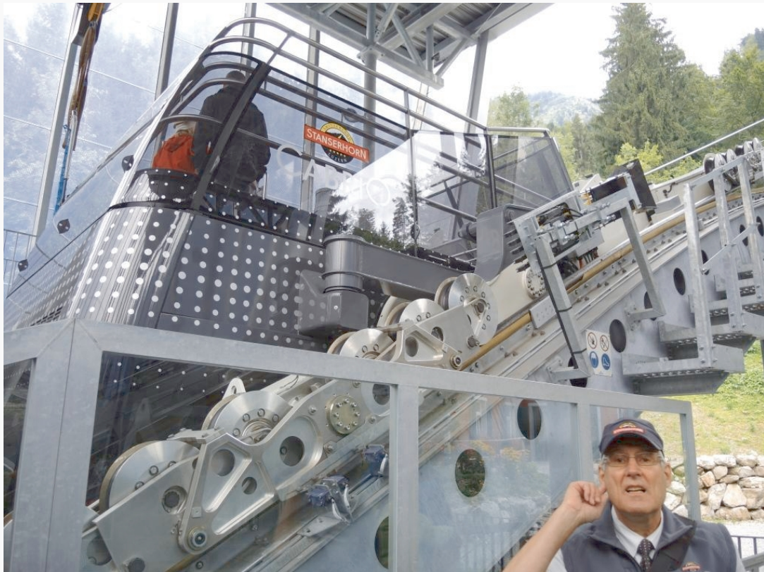
2. Sektion: Die Cabriobahn wurde als Weltneuheit 2012 in Betrieb genommen
