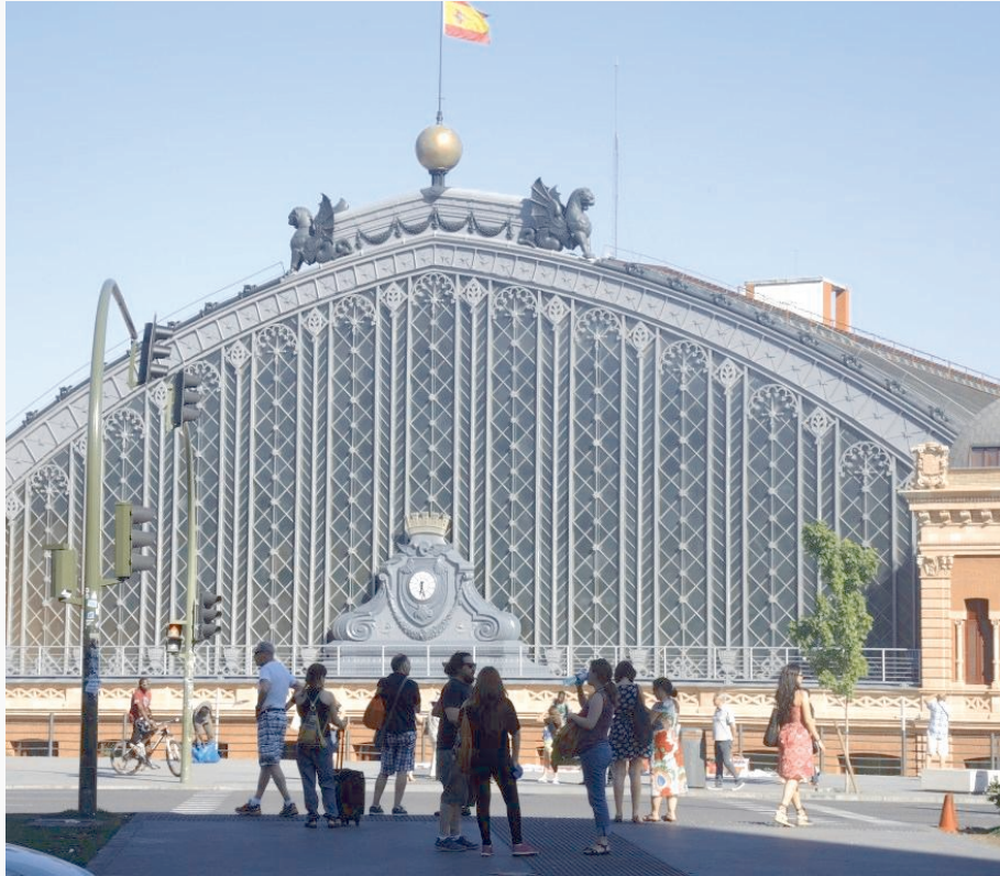
Der alte Bahnhof Atocha in Madrid wurde aufwändig renoviert
