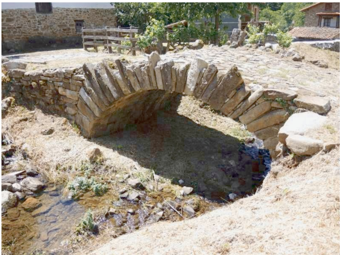
Kleiner Rundgang durchs Dorf: Diese Brücke soll 800 Jahre alt sein
