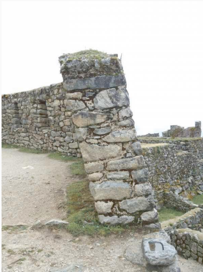
Gegenüber der Ruinen von Qonchamarka liegen diejenigen von Sayaqmarka: Schräge Mauern erhöhen die Stabilität
