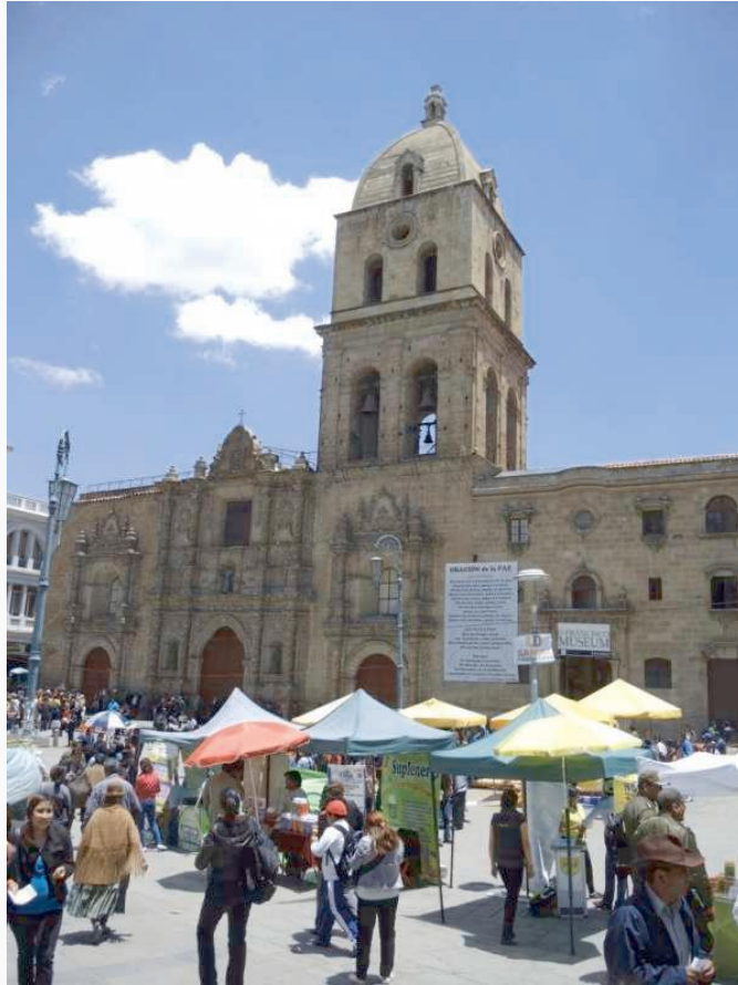
Die Iglesia de San Francisco ist eines der ältesten Gebäude der Stadt
