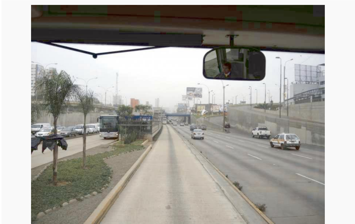
Zusammen mit meiner Stadtführerin Mariela fahren wir heute mit der Metropolitan ins Stadtzentrum. Die Metropolitan ist ein moderner Bus der auf einer separaten Spur zwischen den Spuren der Autobahn quer durch Lima fährt
