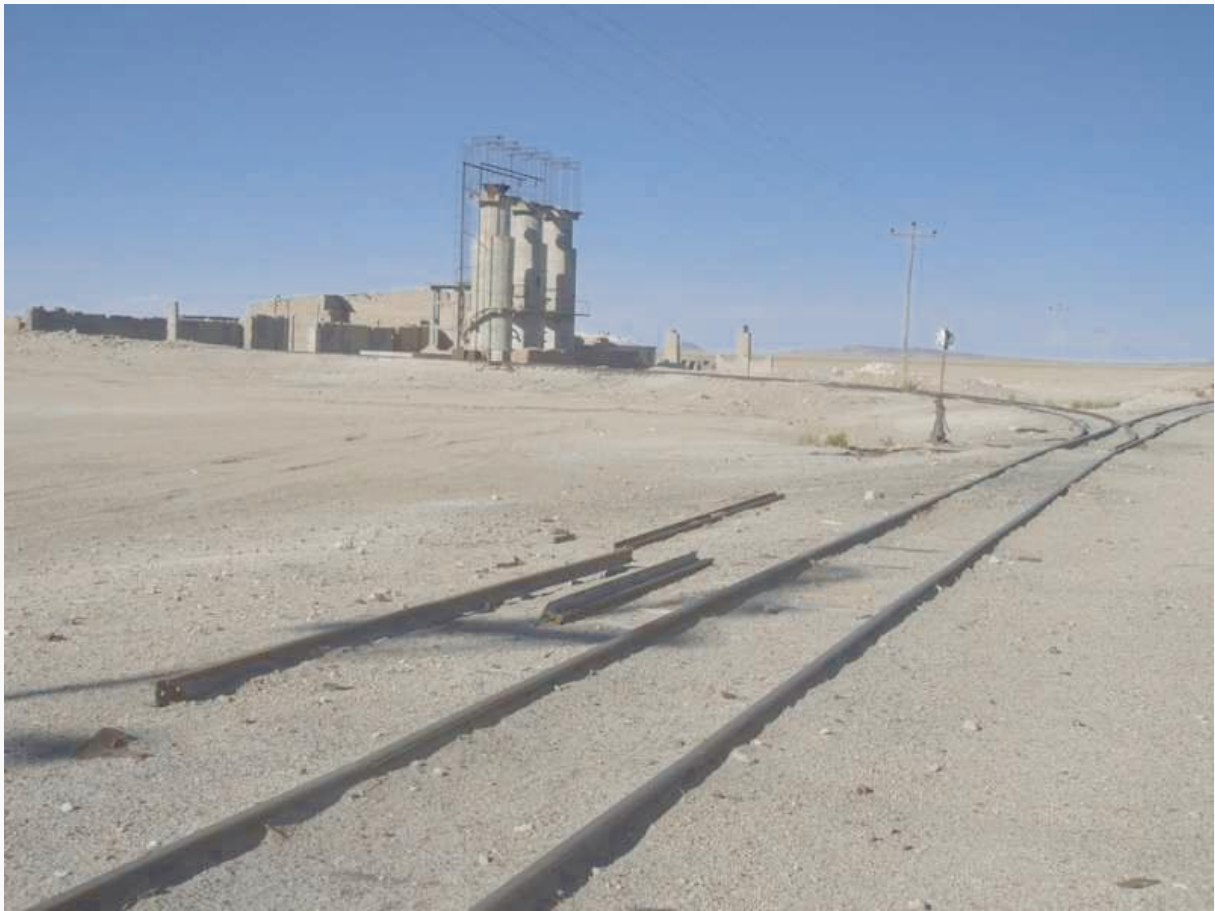
Aufgegebene Borax-Verarbeitungsanlage. Borax wird u.a. zur Keramikherstellung, zur Wasserenthärtung in Waschmitteln und auch z. B. für das Spielzeug Slime (Schleim) verwendet
