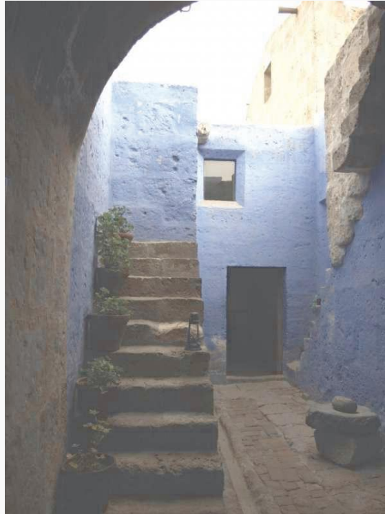
Aufgang zur Dachterrasse
