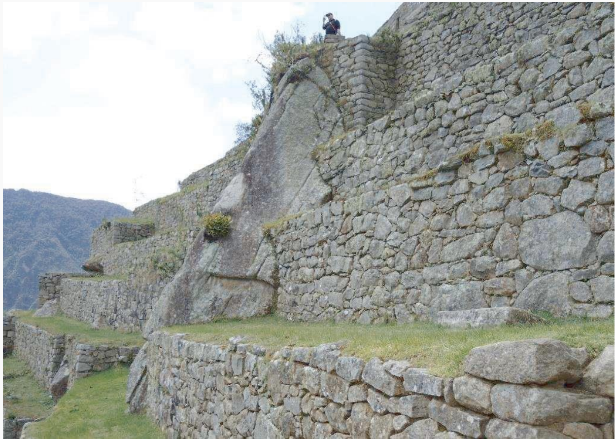
Integration des natürlichen Felsens in eine Stützmauer
