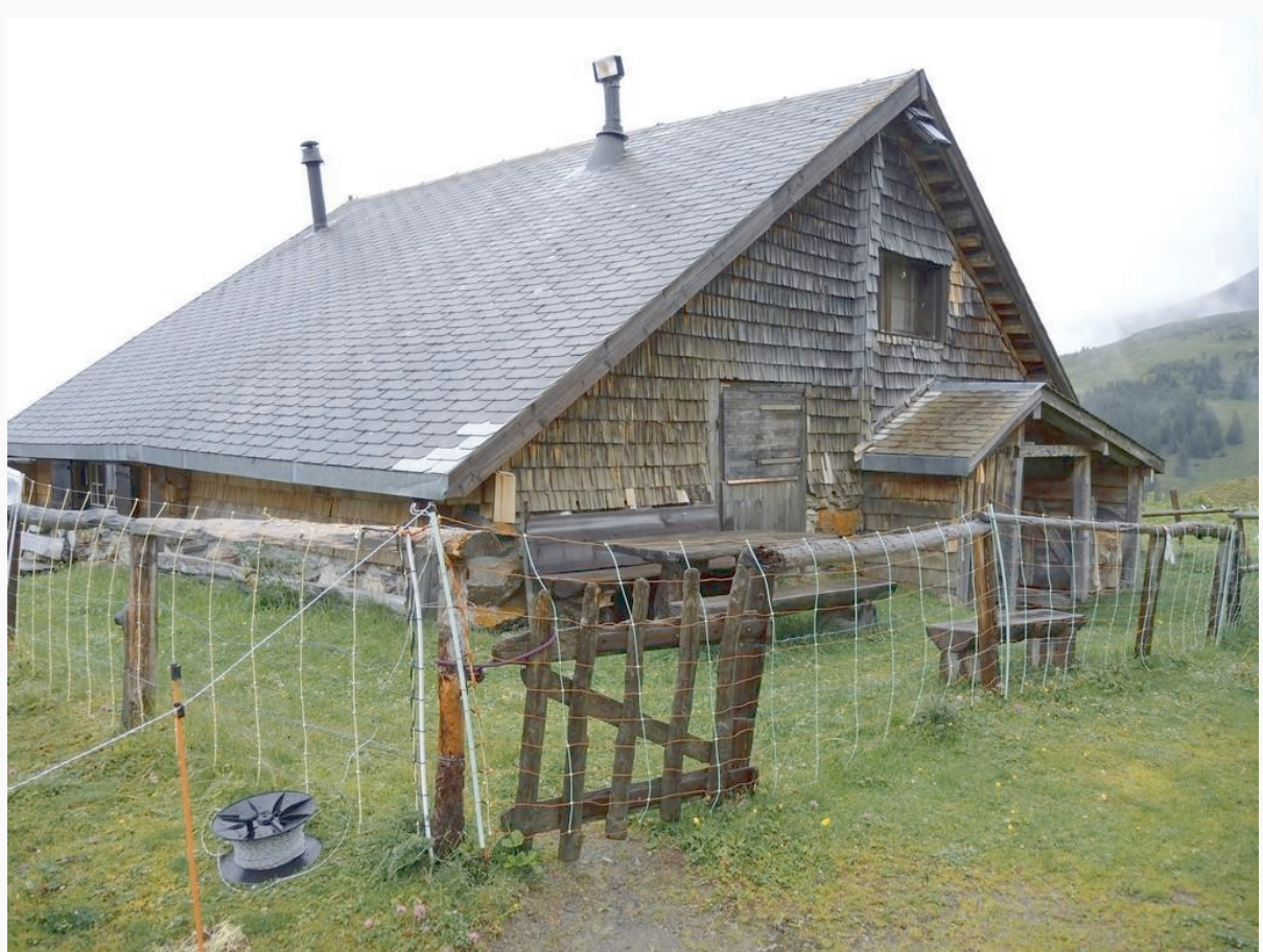
Das ist unsere Unterkunft: Das geschindelte Rota-Hus
