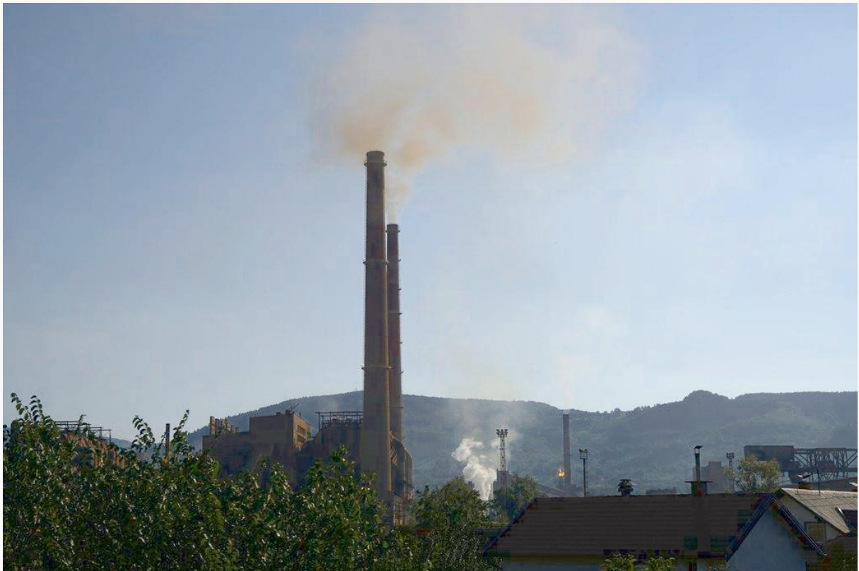
Wir kommen in die Gegend von Zenica mit dem grossen Stahlwerk
