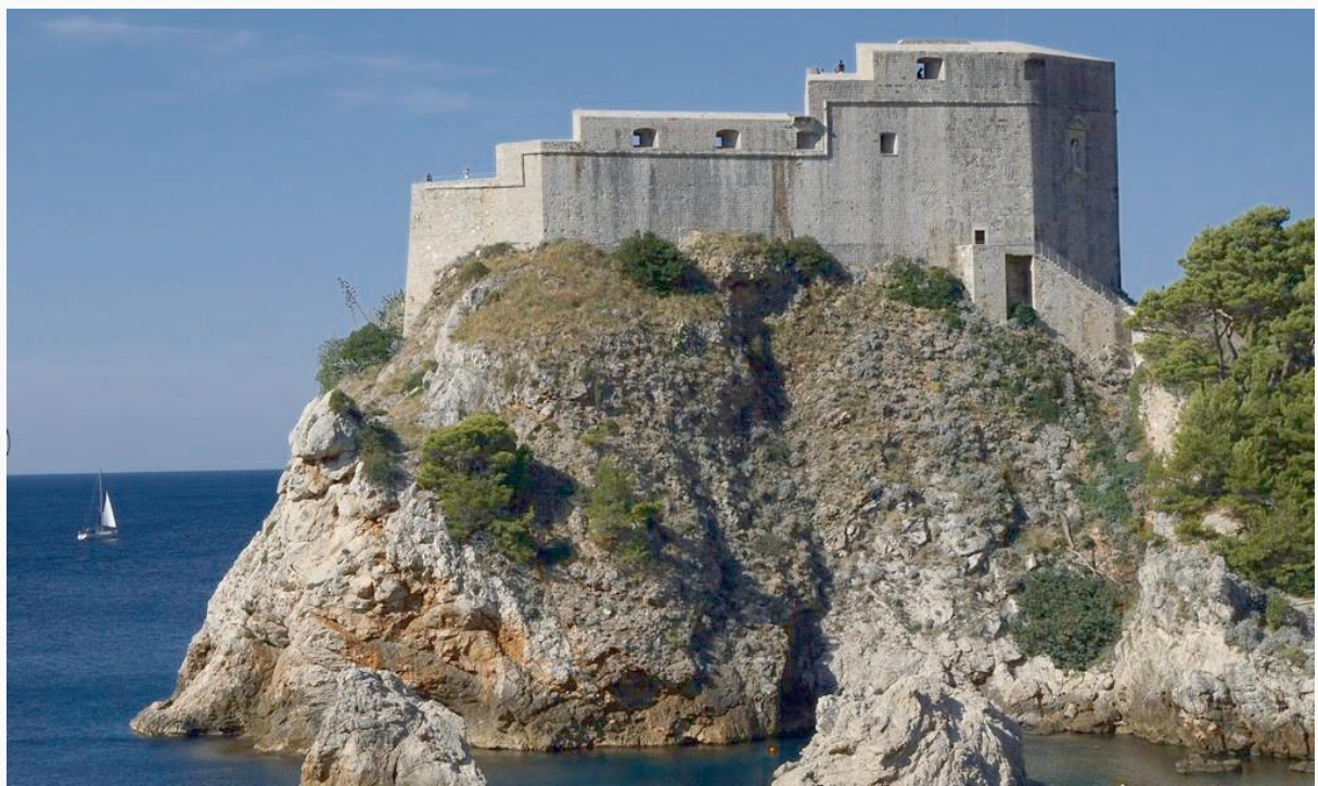
Dubrovnik ist berühmt für seine intakte Altstadt, die Stadtmauer und die Befestigungsanlagen
