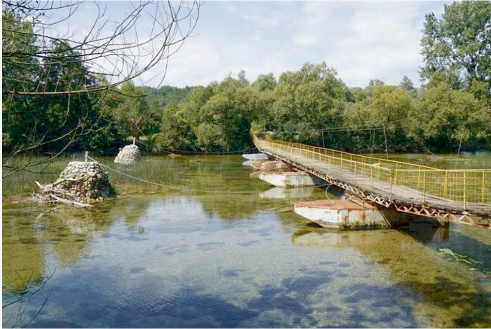
Pontonbrücke über die Sana
