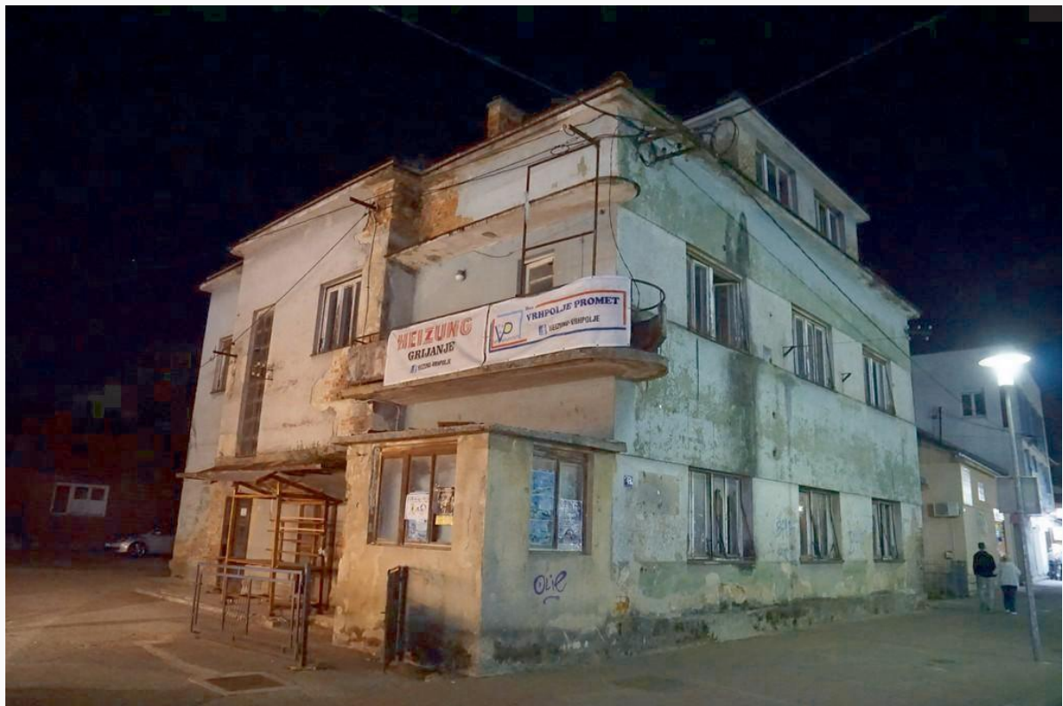
Das ehemalige Verwaltungsgebäude der Kohlenförderung Sanski Most
