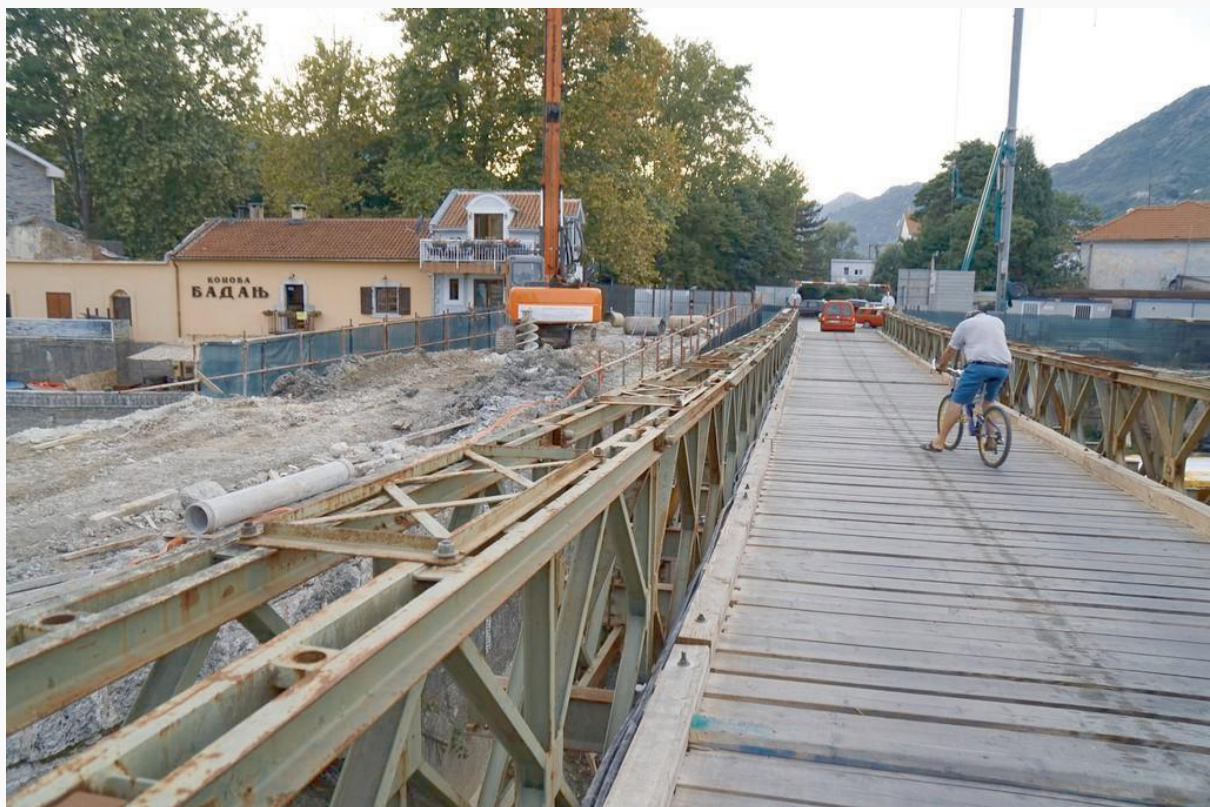
Der kleine Ort Virpazar liegt auf einer Insel im Skadarsee. Eine der Brücken wird gerade erneuert, eine Notbrücke ist in Betrieb
