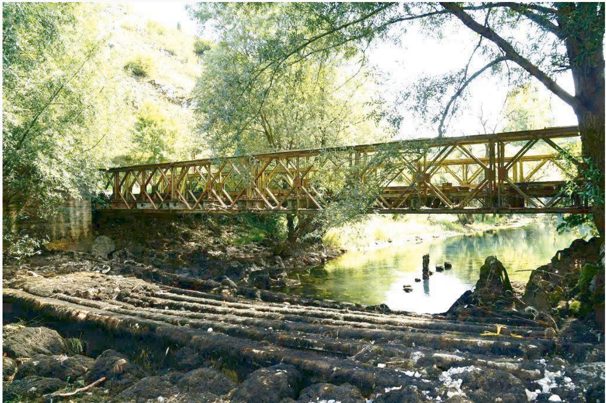
Die alte Brücke (vorne) ist bei einem Hochwasser in den Fluss gestürzt
