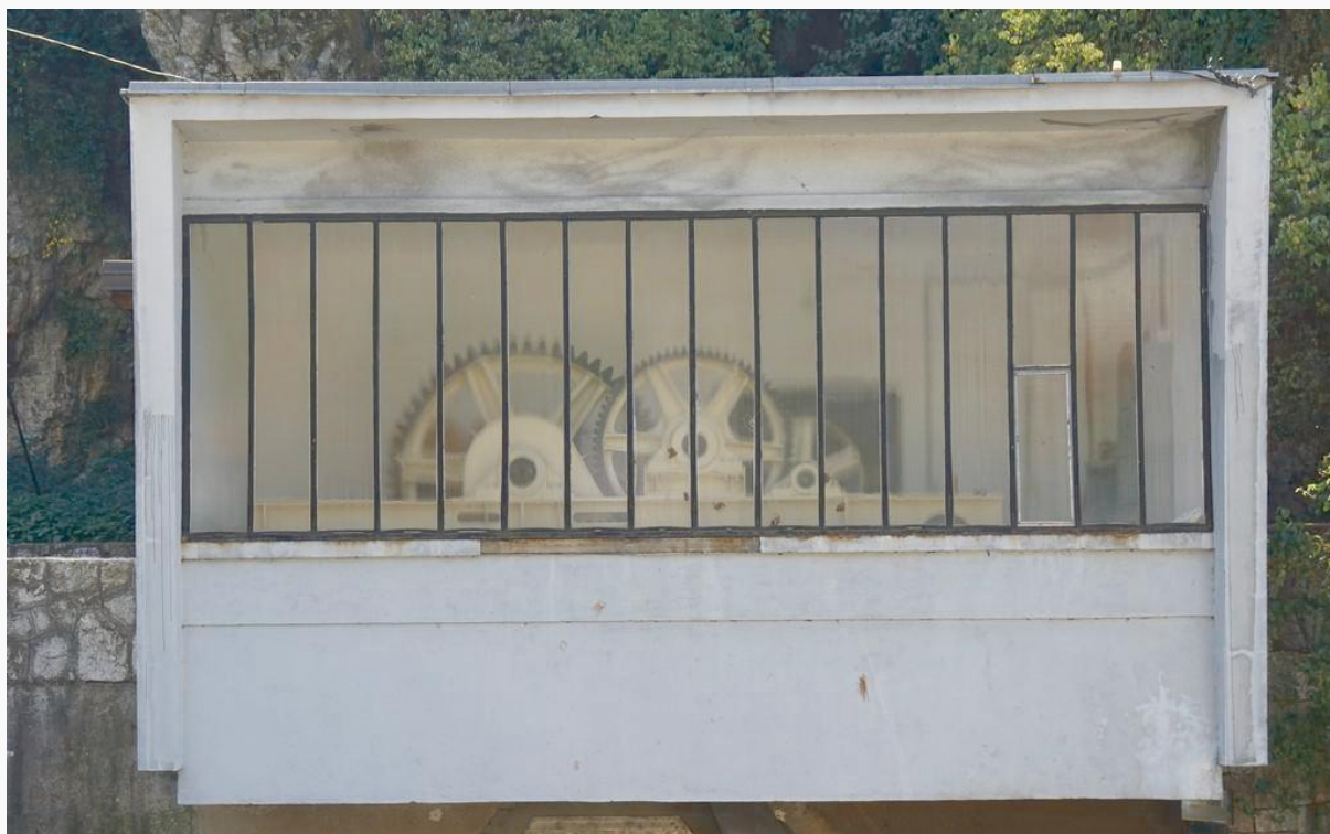
Kraftwerk in der Miljacka
