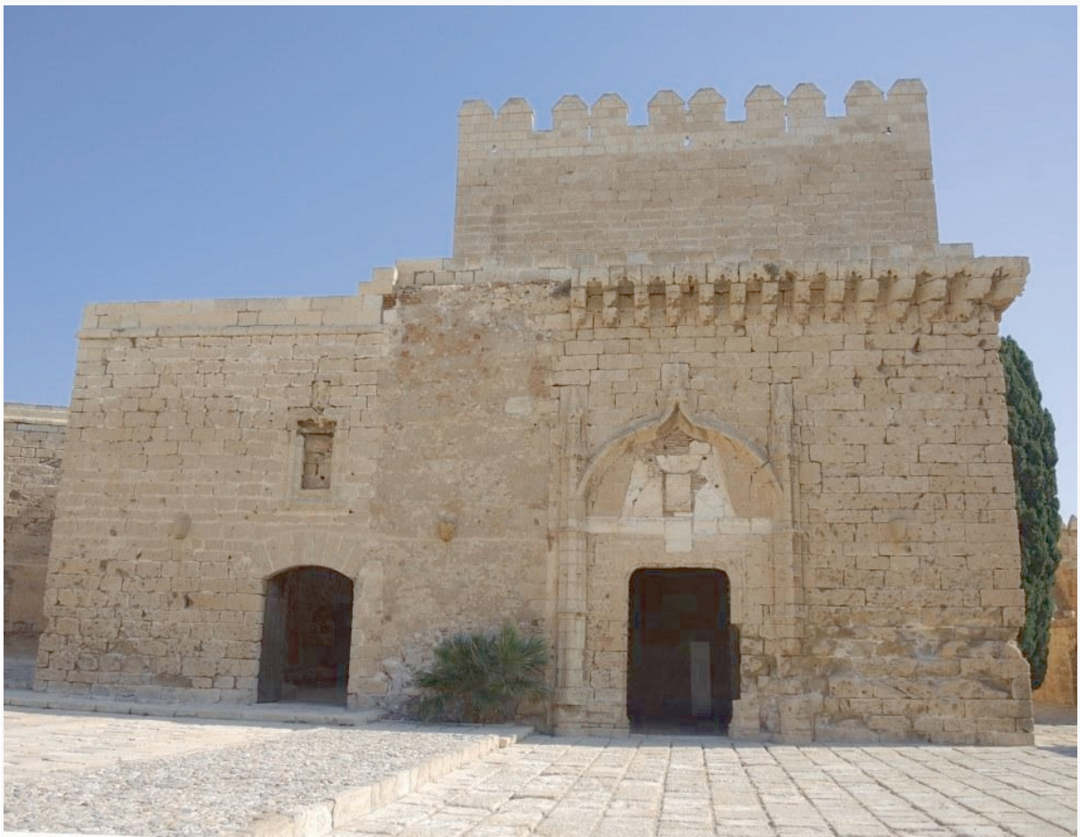
Der nachträglich gebaute christliche Teil
