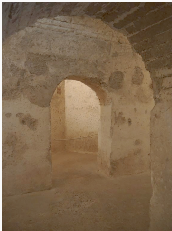
Aljibes árabes: Die unterirdischen Wasserspeicher
