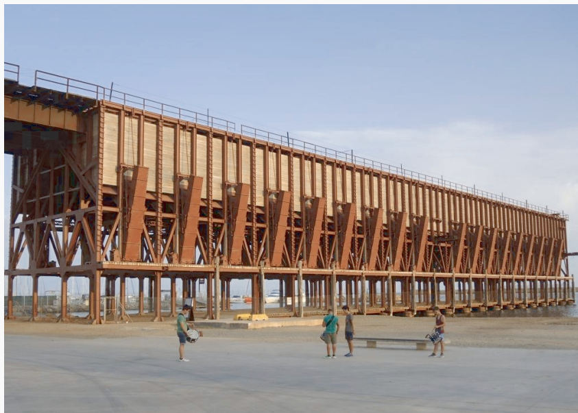
Ehemalige Kohle- und Erzverladestation
