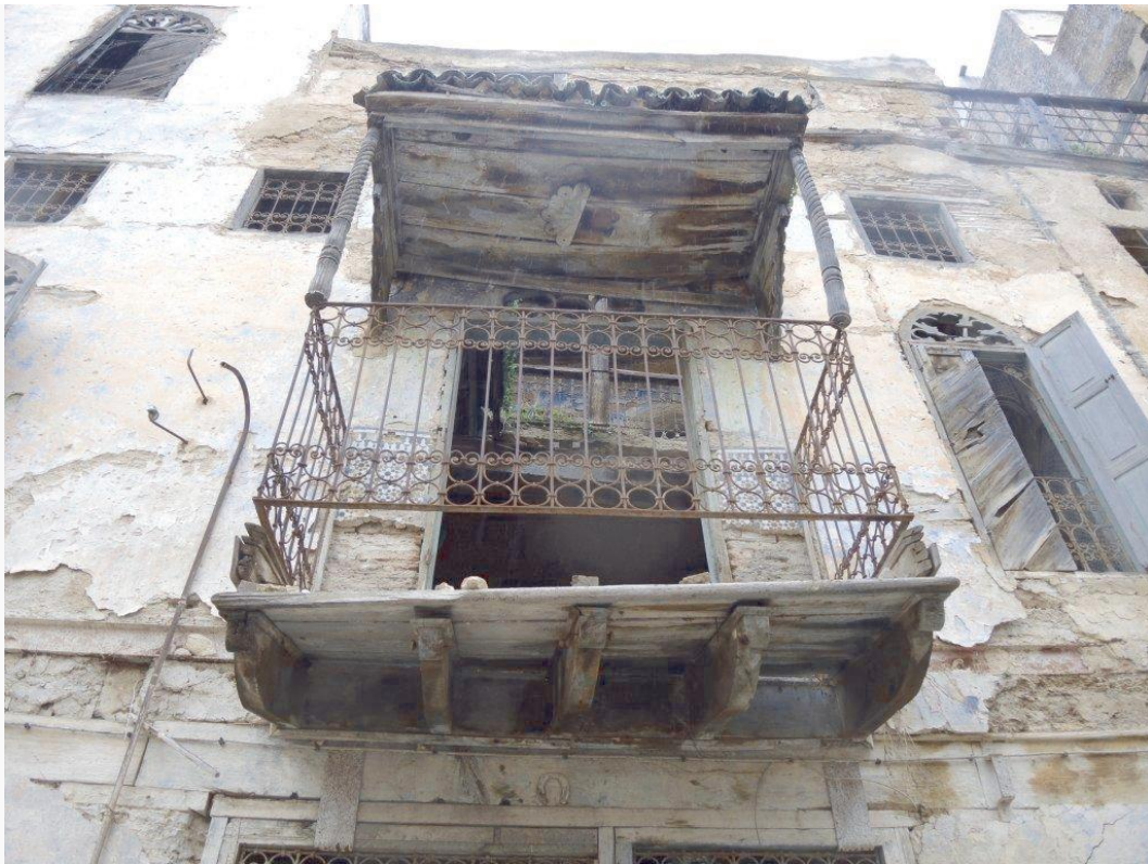
Die ganze Häuserzeile wird aber jetzt mit Unterstützung der UNESCO saniert
