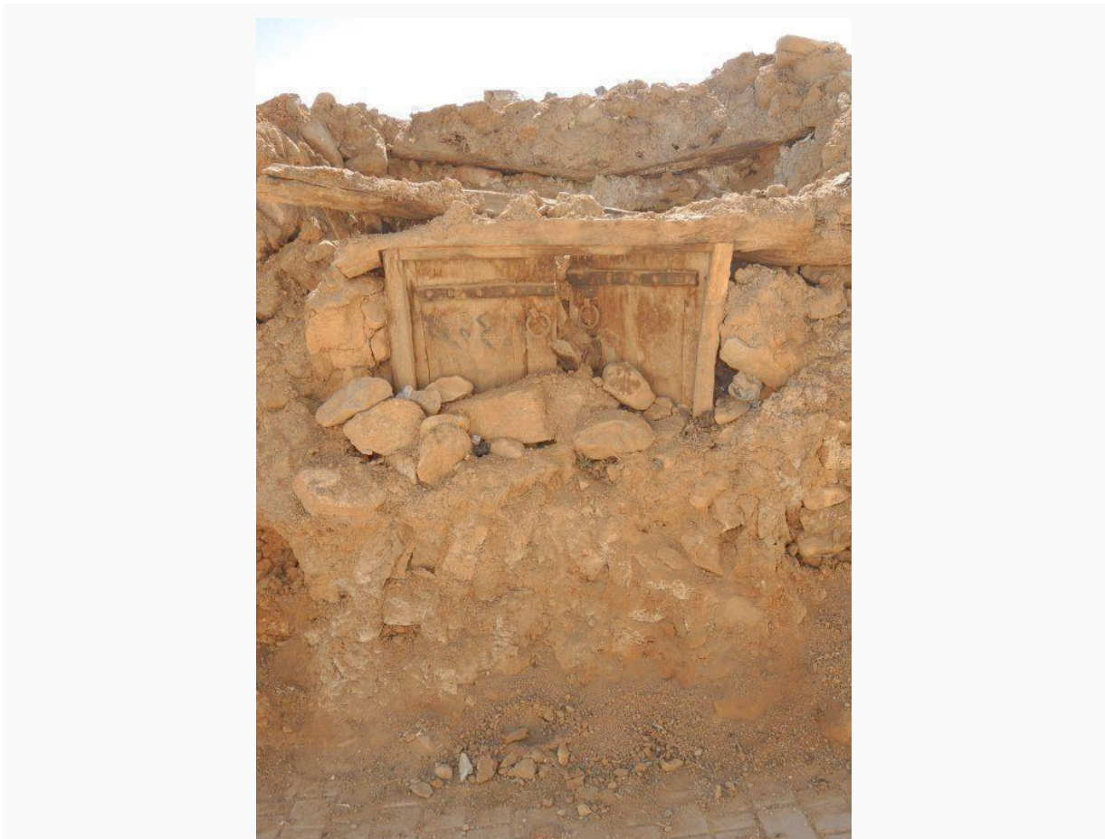
Die traditionell gebauten Lehmhäuser schützen vor Hitze und Kälte, müssen aber alle drei Jahre stark ausgebessert werden oder sie zerfallen
