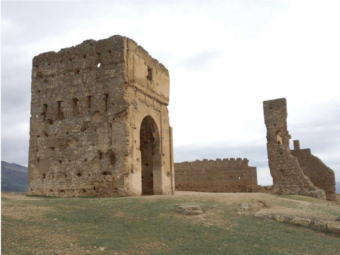
Wir verlassen nun die Medina und finden ausserhalb der Stadtmauern die Ruinen der Merinidennekropole
