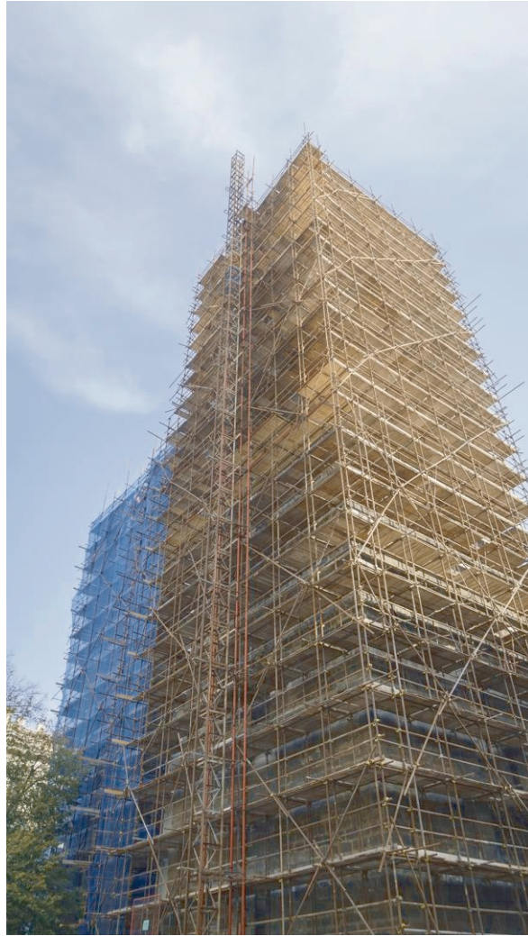
Die Moritzkirche ist gerade eine Baustelle
