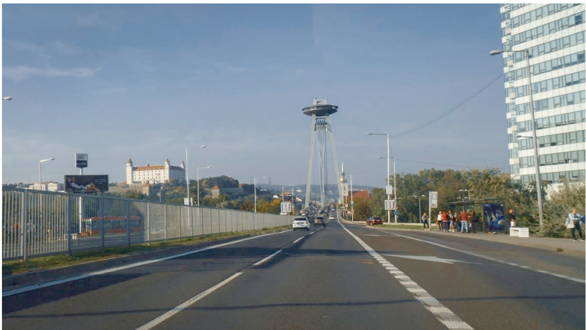
Über die neue Brücke mit der UFO-Aussichtsplattform.
