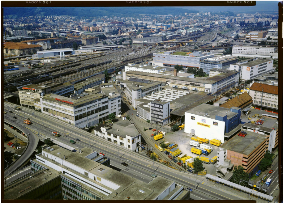
So hat das Maag-Areal vor dem Bau des Prime Tower ausgesehen.
